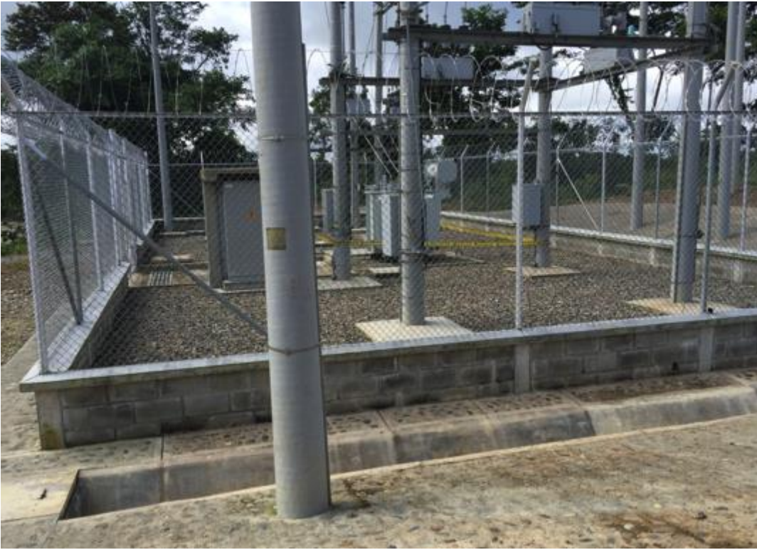
Fig 4.7 - Subestación de Chaquí (1000 kVA)
