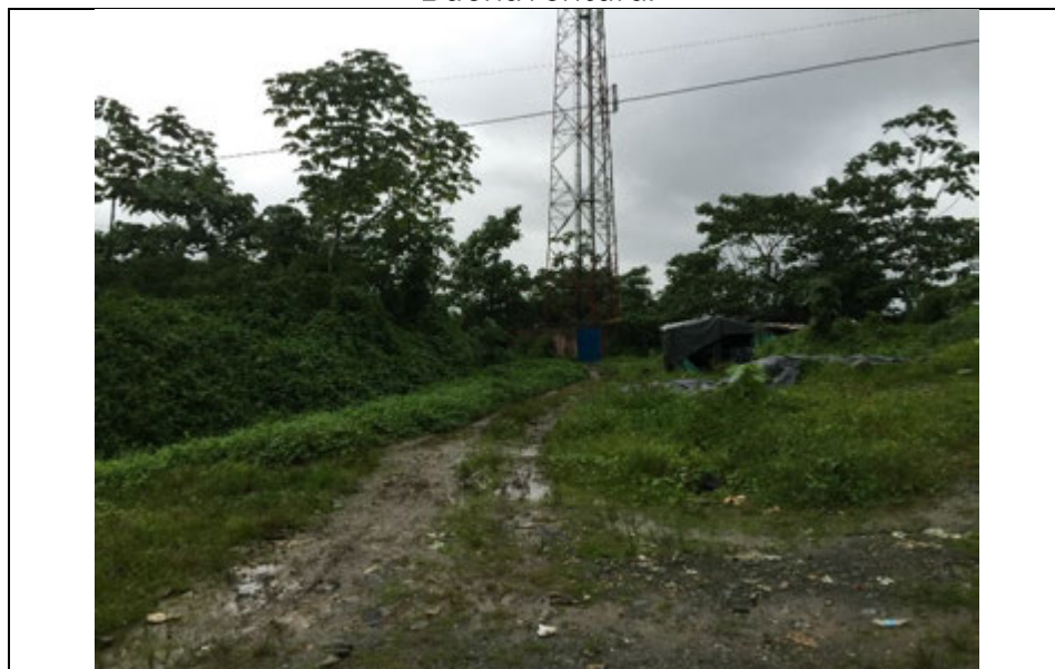
Figura 4.6. Vaso abandonado dentro del Sitio de Disposición Final de Buenaventura.
