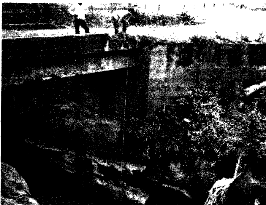
Fig 15 Puente sobre el Río Lagunilla en la vía Ambalema-Cambao. Directamente bajo las bases del puente se aprecian tres sucesivos flujos de lodo, resistentes a la actividad de las aguas, con paredes verticales y límites inferiores erosivos. De la base del puente hacia arriba afloran unos 10 m de arenas sueltas, limos y arcilla rojiza limno-fluviátiles.
