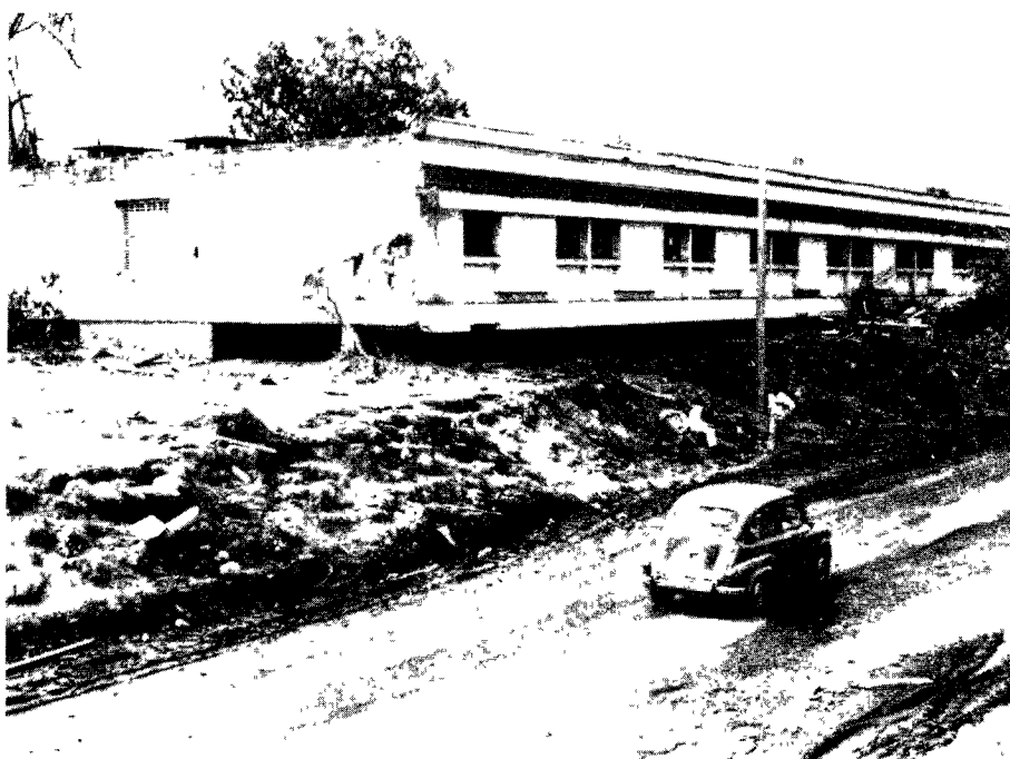
Fig. 9. Otra vista del sector afectado por la fase espesa del flujo de lodo. La edificación corresponde al hospital de Armero, situado al lado de la vía que atraviesa la población y que comunica a Ibagué con Honda. La carretera, limpiada hasta el nivel del asfalto, permite apreciar bien la altura del lodo, en este punto cercana a 2 m.
