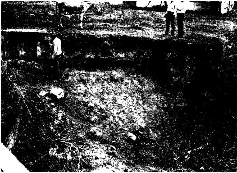
Fig. 20. Margen oriental del Río Lagunilla en la concentración escolar de El Danubio, 3 km al SW de la desembocadura en el Río Magdalena. En la parte baja se aprecian sedimentos arenosos sueltos, recubiertos por un delgado flujo de lodo (pequeño talud vertical), cuyo límite inferior es claramente erosivo. La erosión regresiva, causada aquí por un canal de "cosecheros y desechos", amenaza con destruir las construcciones. El afloramiento se encuentra a unos 100 m del cauce actual del Río Lagunilla.
