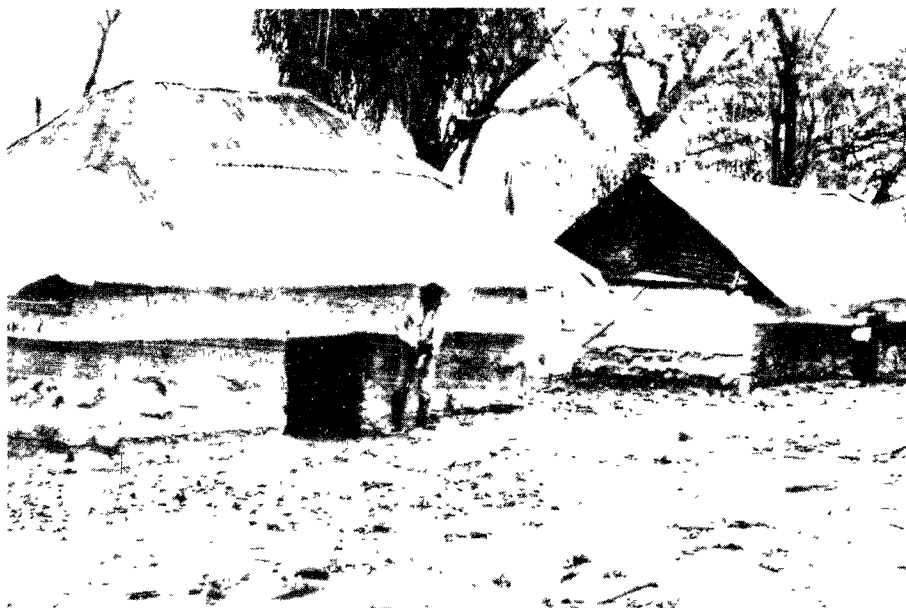
Fig. 14. Construcciones de bahareque (barro y madera) afectadas por el lodo en el caserío de Santuario. Se aprecia que las casas soportaron bien el empuje de la avenida que alcanzó aquí alturas de 1.9 m, evidenciadas por las marcas en las paredes. La capa de lodo, ya seco, tiene apenas unos 90 cm. El flujo avanzó aproximadamente de izquierda a derecha, según lo muestran los troncos orientados; en los muros se notan las huellas de impactos de la carga más gruesas, que descascararon las paredes hasta casi 1.6 m de altura. Foto tomada en enero 25 de 1986.
