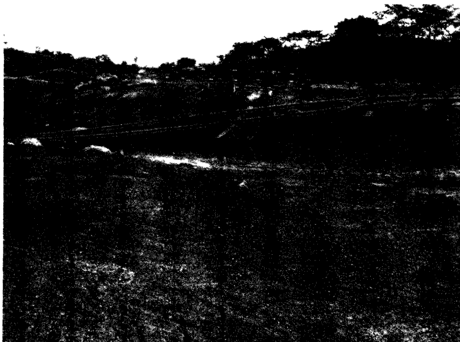
Fig. 16. Toma en el margen oriental del brazo del flujo de lodo que corrió hacia Guayabal. La foto, tomada cerca de la Granja Experimental de la Universidad del Tolima, muestra cómo la energía de las aguas fue suficiente para levantar y desplazar lateralmente los rieles del ferrocarril, incluidos los piolines.
