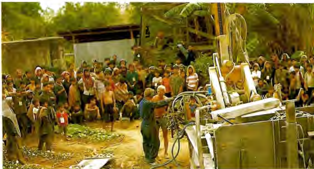
Perforación de un pozo Tailandia 1980
