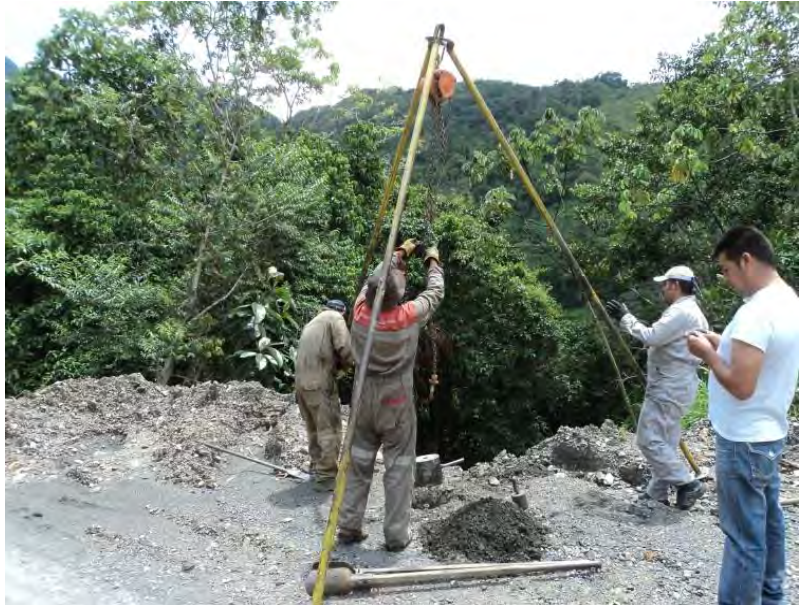
Fotografía 6. Perforación realizada en la zona de estudio
