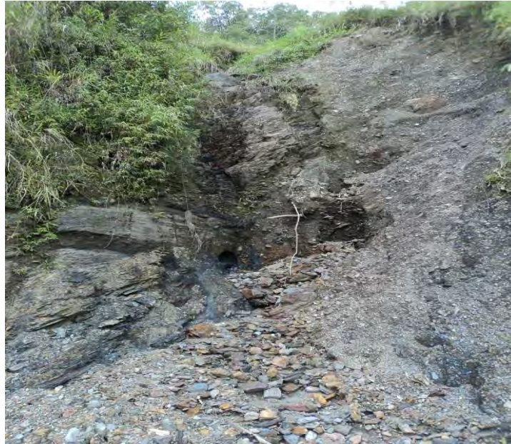
Foto 4. Material arrastrado por el movimiento en masa.
