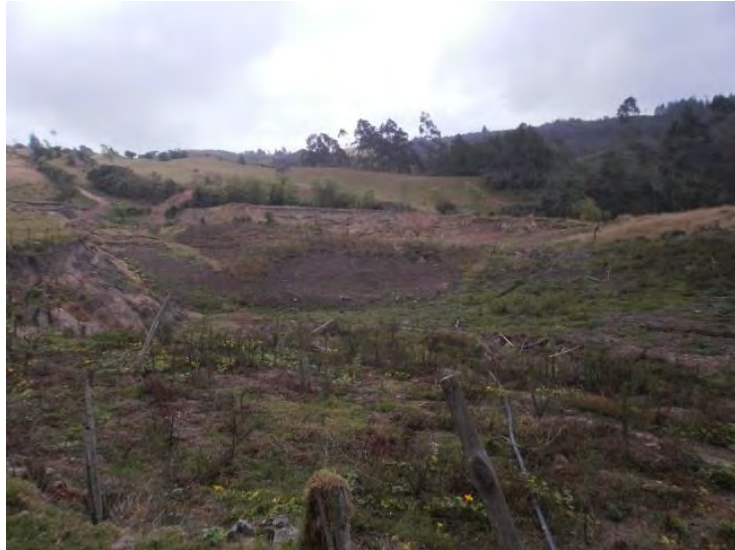
Fotografía 23. PARTE ALTA DEL DESLIZAMIENTO.
