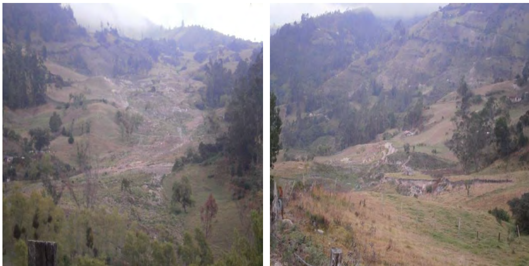
Fotografía 22. PANORAMICA DE LA ZONA DE DESLIZAMIENTO
