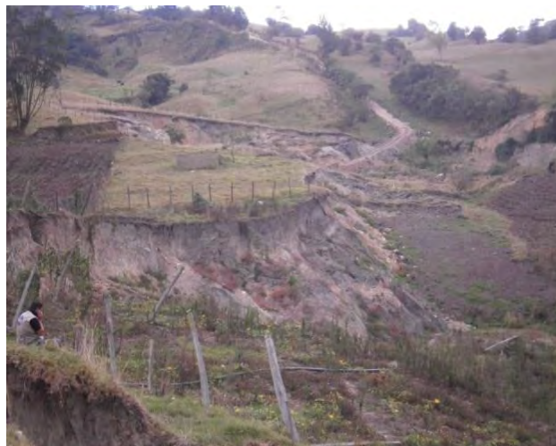
Fotografía 24. Se observa vía veredal.
