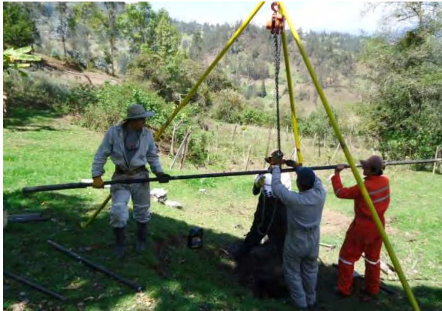
Fotografía 1. EXPLORACION DIRECTA DEL SUBSUELO (SPT)
