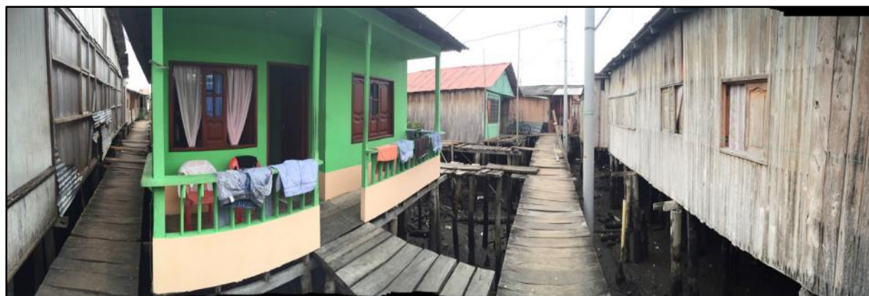
Sistema de “puentes y pasillos” en viviendas palafíticas
