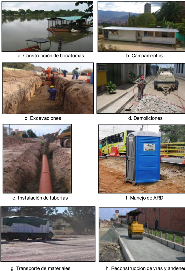
Figura 3-4 Algunas actividades tecnológicas de construcción de acueductos y alcantarillados
