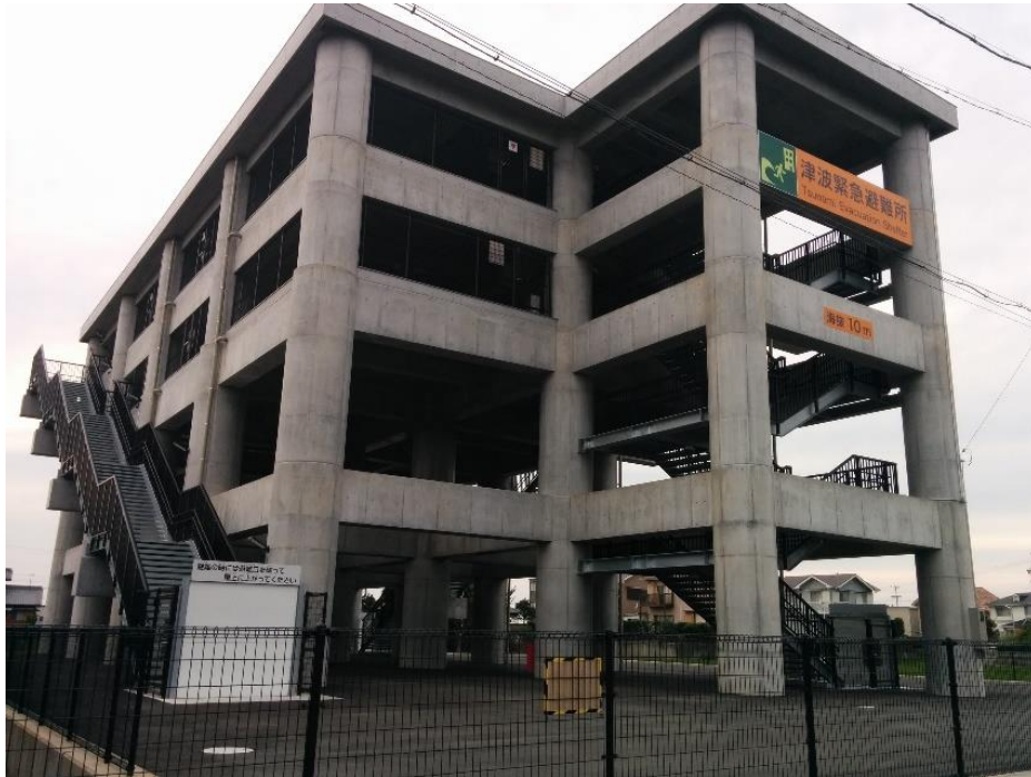
Torre de Evacuación de Tsunamis (Ise City, Mie)
