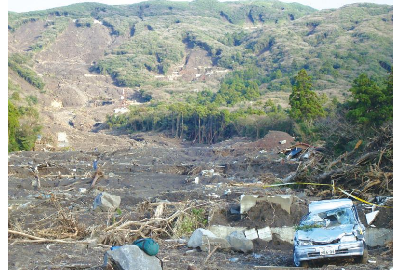
Derrumbes causados por el Tifón 26 de 2013 en la isla Izu Oshima
