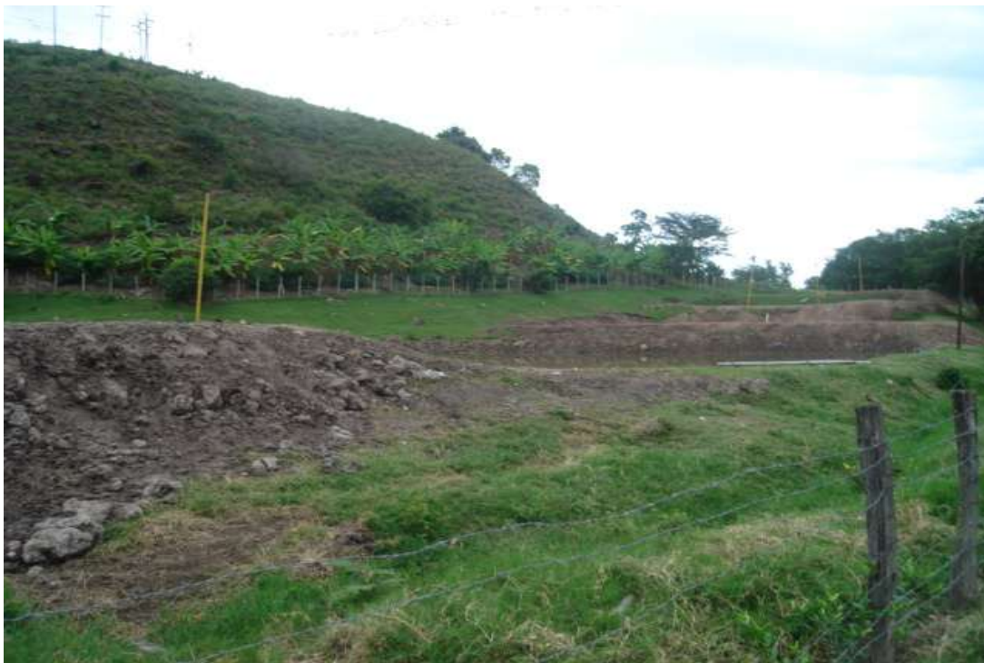
Figura 13. La construcción de estanques genera alto impacto en el recurso suelo
