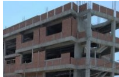
Construcción del Hospital
