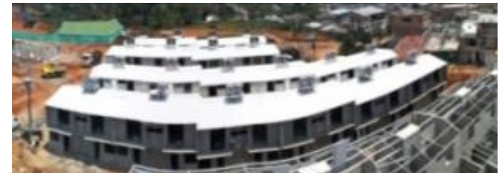
Avance Construcción Vivienda Urbana – Los Sauces I
