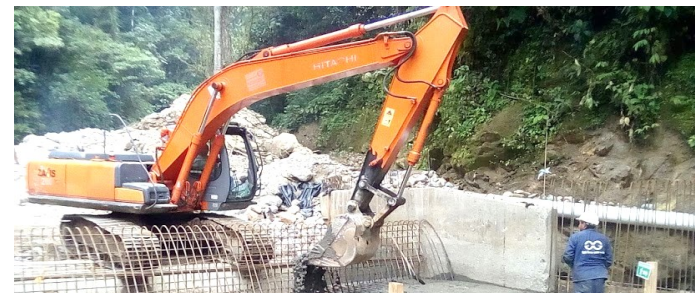
Trabajos Bocatoma Definitiva
