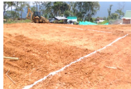
Avance Obras Preliminares
