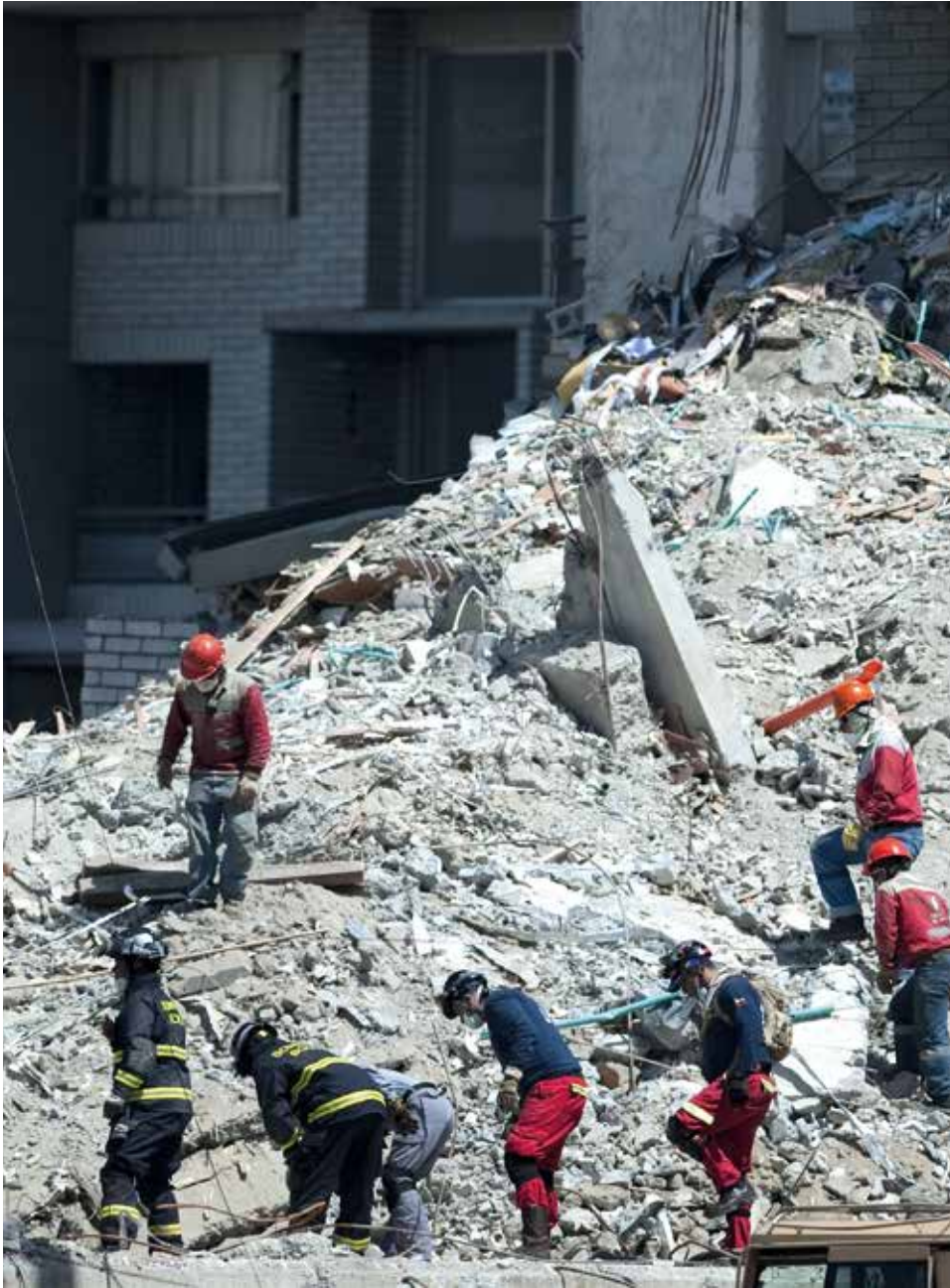
La tragedia del Space fue en la noche. Con las luces del día las montañas de escombros del edificio causaron estupor. AFP • Raúl Arboleda
