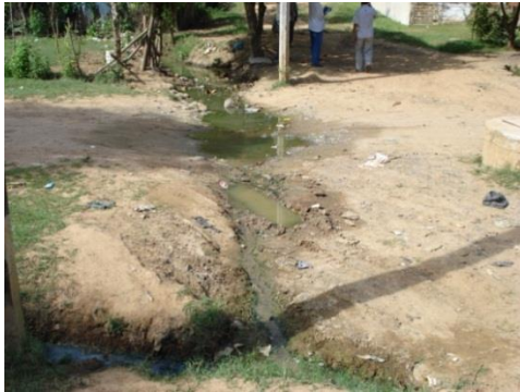
Foto. Agua residual que drena por las calles, causando erosión hídrica, y con el incremento de las lluvias inundación, no hay pavimento en la vía y se generan surcos sobre el terreno. Barrió Palma Soriana. FUENTE PMGRP
