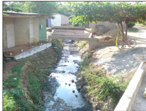
Foto Canal con sección irregular y lecho en tierra. FUENTE PMGRP
