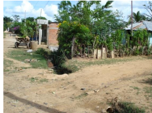
Foto. Canal que evacua el agua de escorrentía y agua residual. Barrio Palma Soriana. Tubería de Poca sección FUENTE PMGRP
