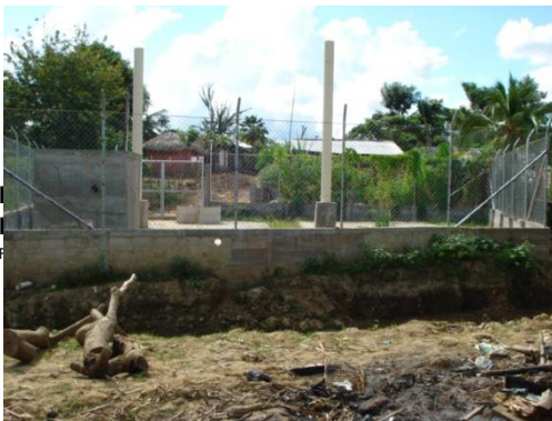
Foto. Estación de bombeo aguas residuales. Barrio Palma Soriana FUENTE PMGRP
