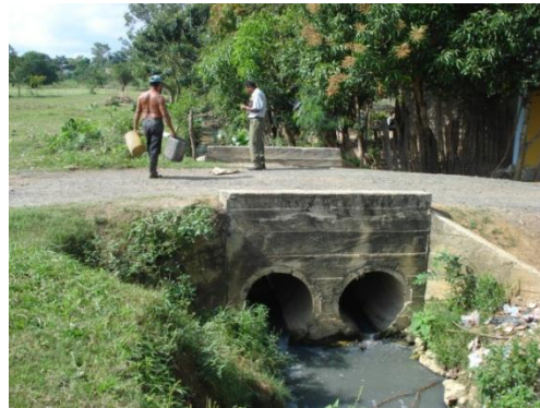
Foto. Sitio de inundación Barrio Centenario. Estructura de paso, alcantarilla con doble tubo en concreto d = 1 m Aguas arriba. FUENTE PMGRP
