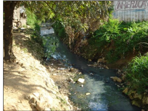
Foto. Aguas abajo punto de Intersección de los canales. Sección irregular y lecho del arroyo en tierra. Barrio San José. FUENTE PMGRP
