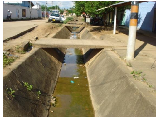
Foto. Arroyo el desorden Sección trapezoidal revestida en concreto. Carrera 16 con Calle 20. FUENTE PMGRP
