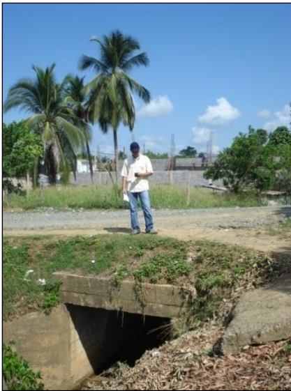
Foto. Estructura de paso. Alcantarilla tipo Box, Sitio donde se recoge el agua que nace en la parte trasera de Rápido Ochoa, en dirección hacia el barrio Centenario. FUENTE PMGRP
