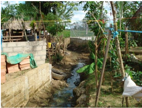
Foto. Canal de evacuación aguas abajo. Barrio Palma Soriana. FUENTE PMGRP
