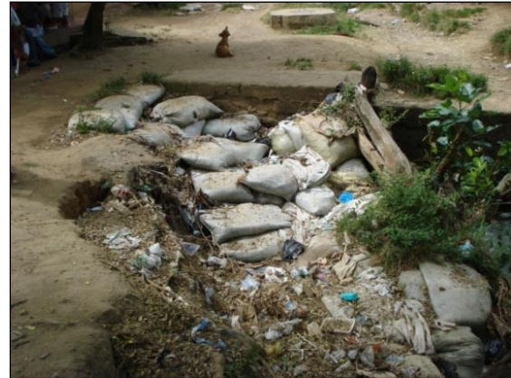
Foto. Bolsa suelo, dispuestos en el sitio, para mitigar la erosión.
