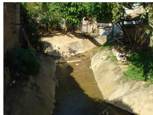
Foto. Arroyo el Desorden Sección trapezoidal revestida en concreto FUENTE PMGRP
