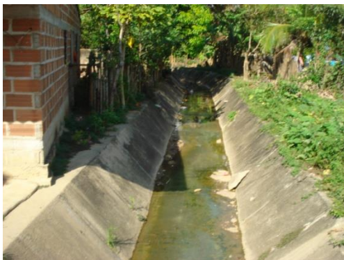
Foto. Arroyo el Desorden Sección trapezoidal revestida en concreto. FUENTE PMGRP
