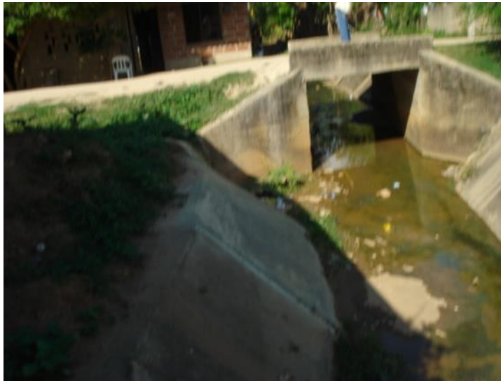
Foto. Arroyo el Desorden. Estructura de paso tipo Box
