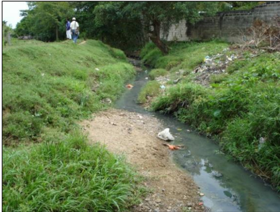
Foto. Sitio de deposición de arenas arrastradas producto de la erosión que se presenta en el canal.
