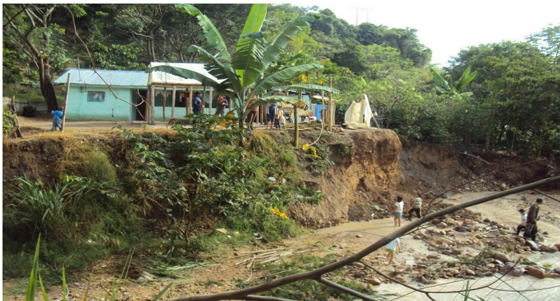
Vivienda afectada sector de anayaco quebrada la TORO
