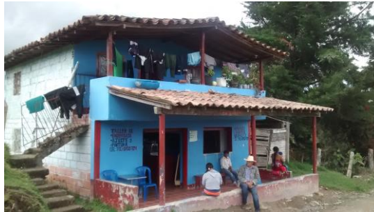
Figura 22. Vivienda expuesta a movimientos en Masa en la vereda La Lana
