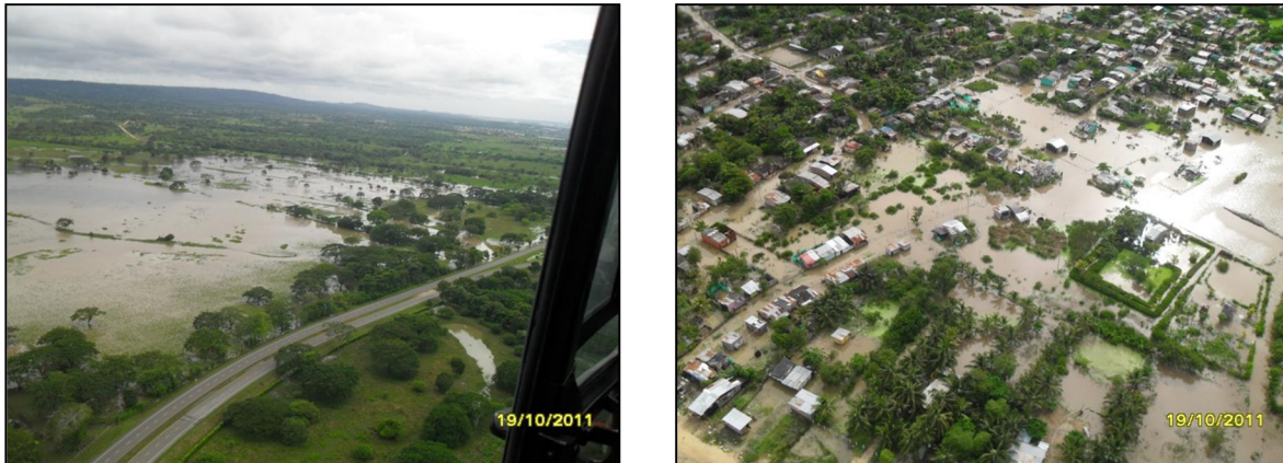
Ilustración 13. Inundaciones en diversos sectores del distrito debido a las lluvias producidas por el fenómeno de La Niña 2011. Izq. Vía a la Cordialidad, der. Sector Barrio El Pozón.
