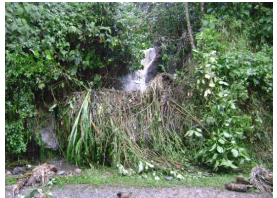
imagen- descarnamiento quebrada, Vía Caldono-Pescador. Fuente – Alcaldía Municipal.
