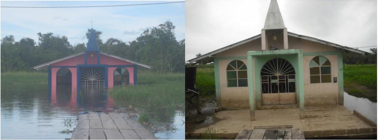
Figura 6. Iglesia afectada por la inundación. Observa la mancha dejada por el agua.
