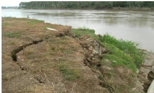
Figura 5. Deslizamiento en la orilla del Casco Urbano del Municipio de Murindó
