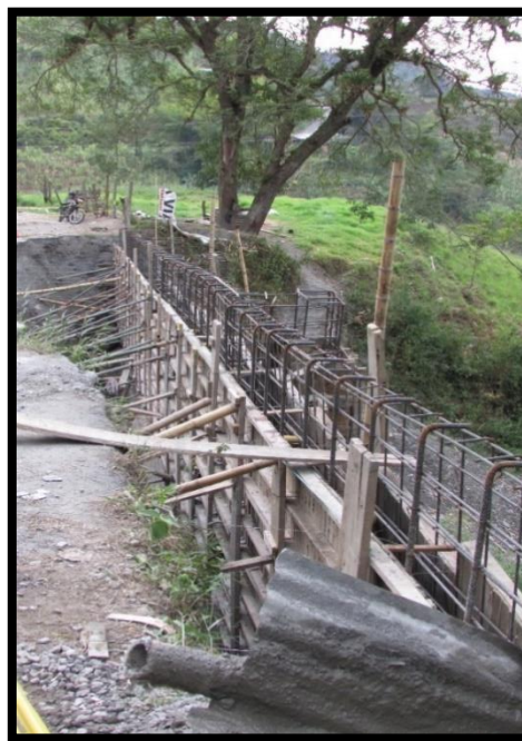
Figura 15. Construcción de muros de contención en la Vereda El Tigre. 74°21'13" W;
