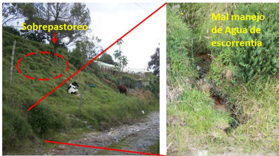
Figura 10. Sobrepastoreo y mal manejo de agua de escorrentía en talud. Sector La Frontera. Municipio de La Unión.
