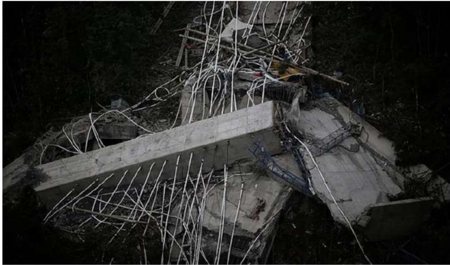
Finaliza operación de rescate de cuerpos tras colapso del puente Chirajara. Foto: Colprensa
