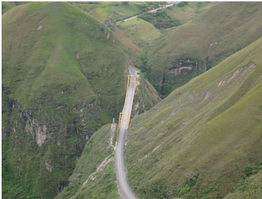
*Puente sobre el Río Juanambú
