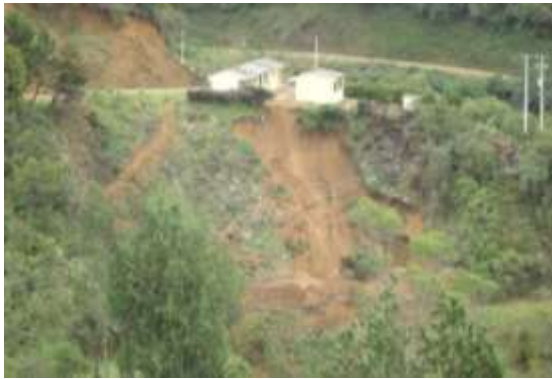
Foto 3 Y 4. Deslizamiento que afecta la infraestructura física de la Escuela de la Vereda Pisiltes y deslizamiento que afecta líneas vitales del municipio, sector Balalaika-La Corralira.
