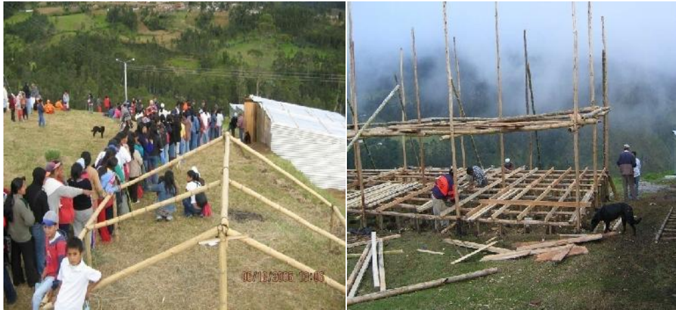
Imagen 18. Construcción de módulos albergue Potreros
