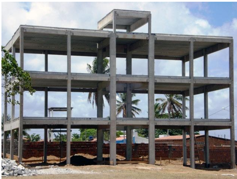
Figura 3.4 Pórtico en concreto
