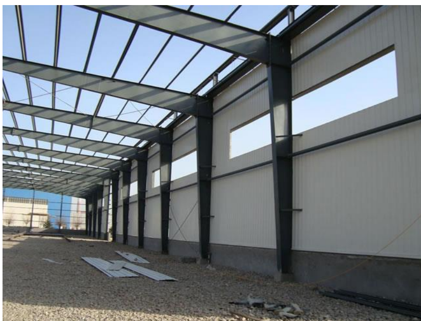
Figura 3.5 Pórtico de acero
