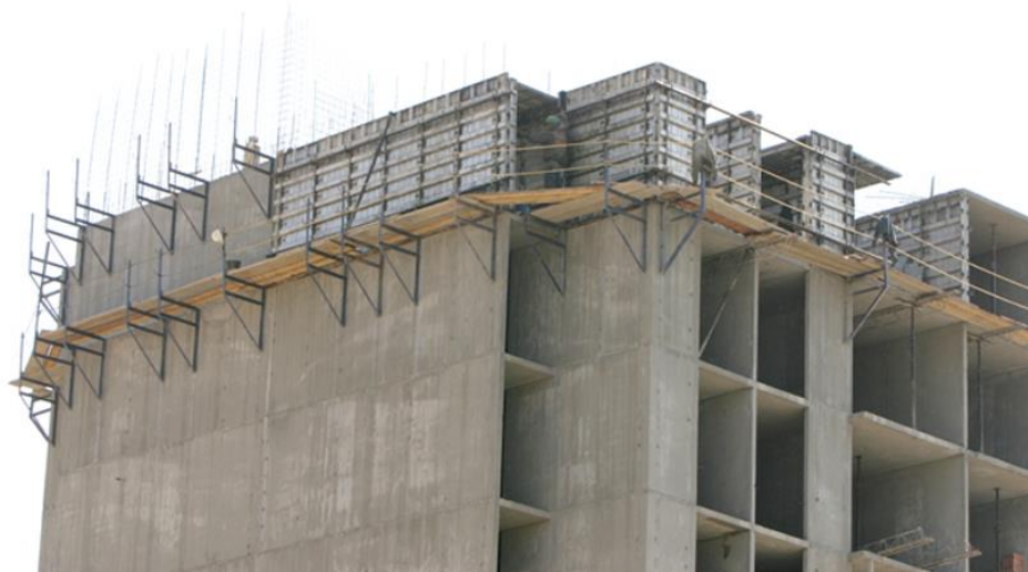
Figura 3.3 Muros vaciados en concreto reforzado
