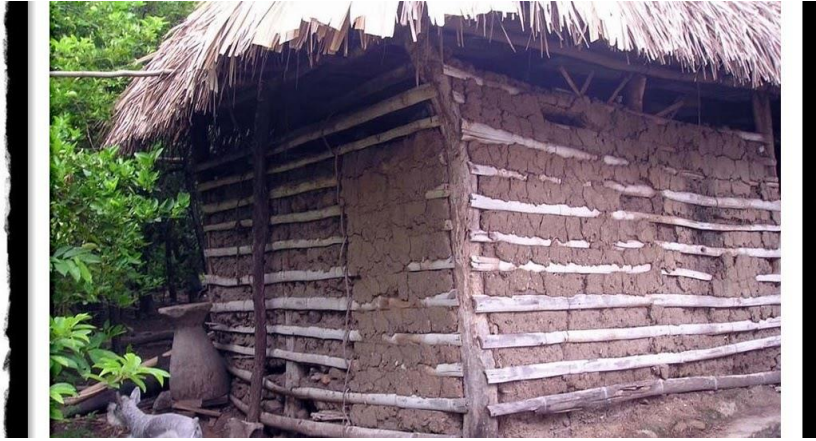
Figura 3.2 Muros de Bahareque
