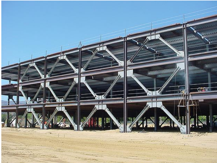
Figura 3.6 Pórtico en acero arriostrado
