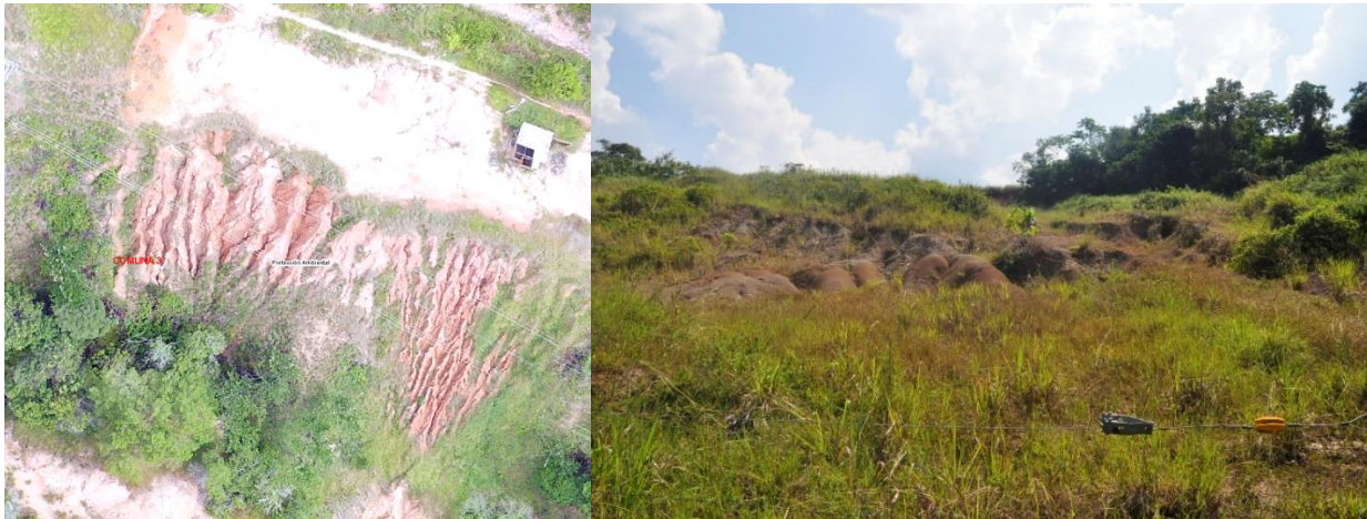
Figura 5-4: Cárcavas en la zona Urbana de Barrancabermeja, Comuna 3 y zona de expansión Sureste.
