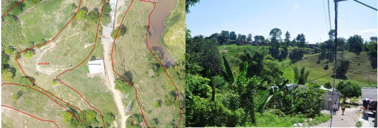
Figura 5-9: Vista típica de la reptación presente en la zona urbana.
