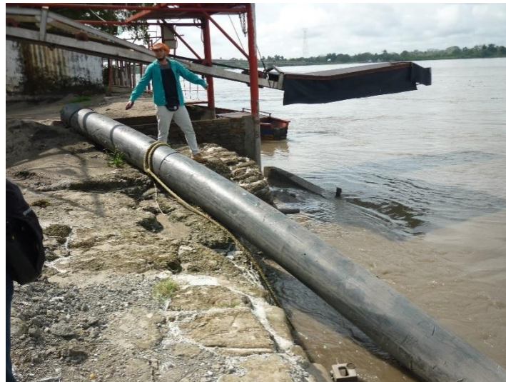
Figura 5-15: Muro de contención sobre la unidad de Plano o Llanura de Inundación.
