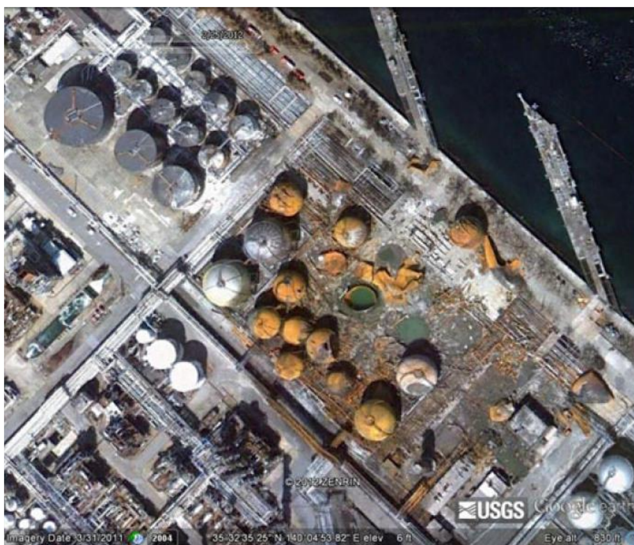
Figura 1. a. Tanques incinerados, refinería de Sendai afectada por el tsunami. b. Parque de tanques de GLP, refinería de Chiba afectados por incendios y explosiones provocados por el terremoto. Tomado de (Krausmann & Cruz, 2013).
