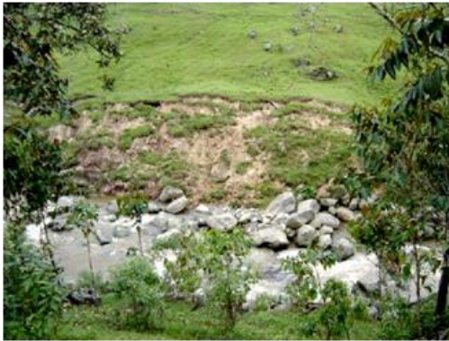
Foto 2.16 Detalle de uno de los sectores afectados por procesos de inestabilidad en la ladera derecha del río Negro. Nótese la alta intervención de la ronda que implico la deforestación total de la misma.
