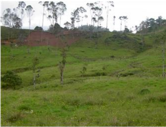
Foto 2.3. Uso extensivo de ganadería con sobre-pastoreo produciendo erosión por escorrentía y remoción en masa.
