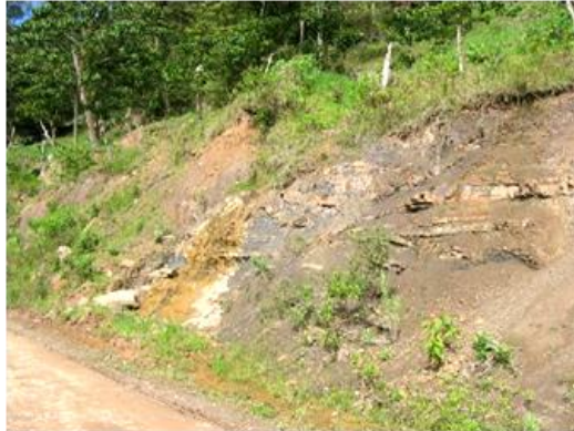
Foto 2.12 Detalle de niveles de lutitas y arcillolitas aflorando sobre la margen derecha de la vía, nótase además la presencia de aguas subsuperficiales.
