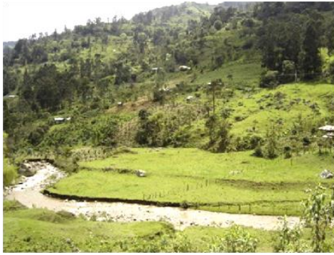
Foto 2.14. Detalle de un tramo de las márgenes del río Negro, nótese la alta intervención del mismo y la socavación de la margen derecha.
