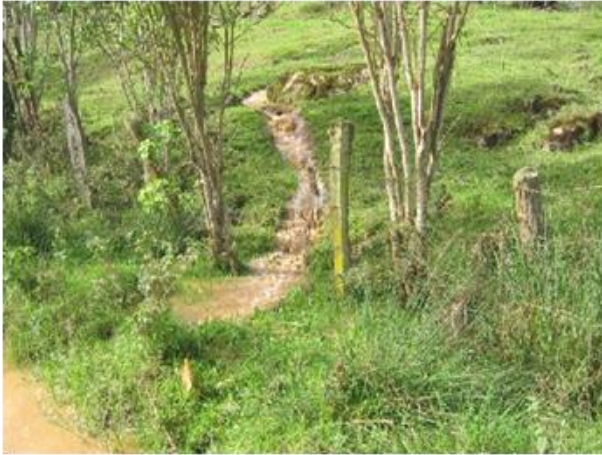
Foto 2.10. Detalle del caudal y condiciones del mismo proveniente del escape de la línea de conducción del acueducto veredal.
