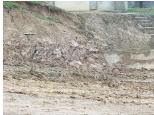
Foto 1.4 Movimiento de tierra
