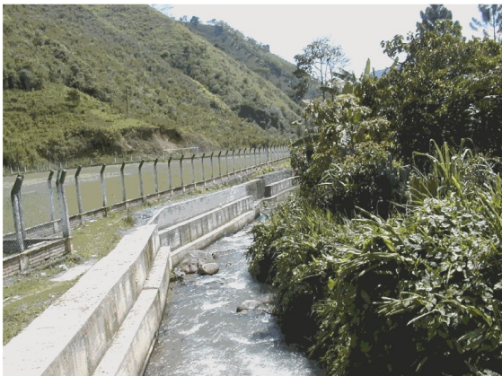
Figura 15. Obra de protección en el estadio Municipal
