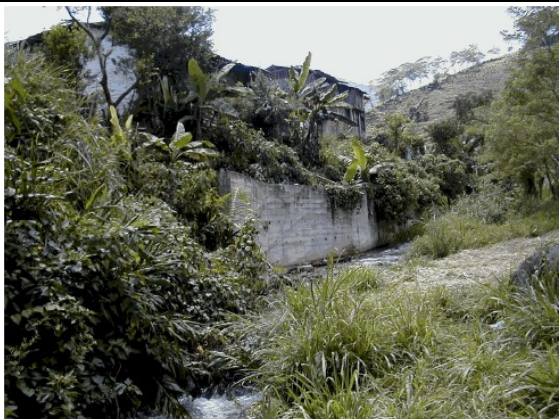
Figura 17. Muro de protección sector margen derecha entre carreras 4ª y 5ª
