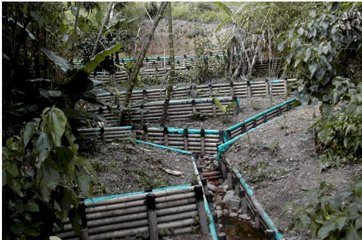
Figura 19. Detalle de las obras biomecánicas realizadas en la corona del deslizamiento en el río Totuí
