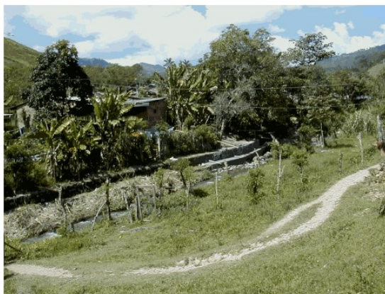
Figura 16. Obra de protección sector del Matadero
