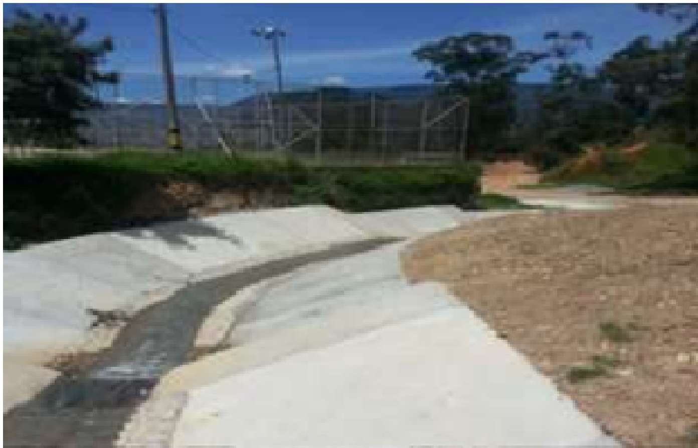
CONSTRUCCIÓN DE OBRAS HIDRAÚLICAS Y OBRAS COMPLEMENTARIAS EN LAS QUEBRADAS, ZANJÓN DEL ALTO, PELADEROS Y PRIMERA ETAPA DEL SESTEADERO PARA LA MITIGACIÓN Y PREVENCIÓN DEL RIESGO. ITAGUI – ANTIOQUIA. UNGRD, 2016. 🔗
