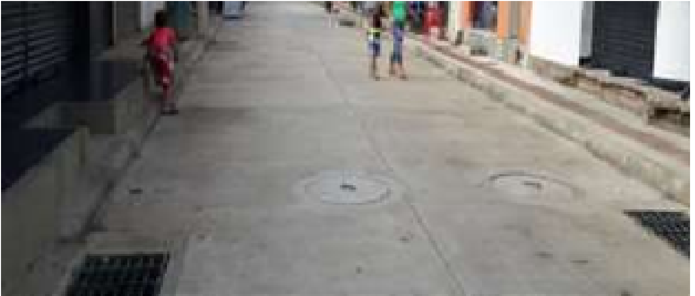
ADECUACION Y RECUPERACION DE LAS REDES DE ALCANTARILLADO Y ACUEDUCTO EN EL BARRIO SAN NICOLÁS. TARAZÁ – ANTIOQUIA. UNGRD, 2016. ↗
