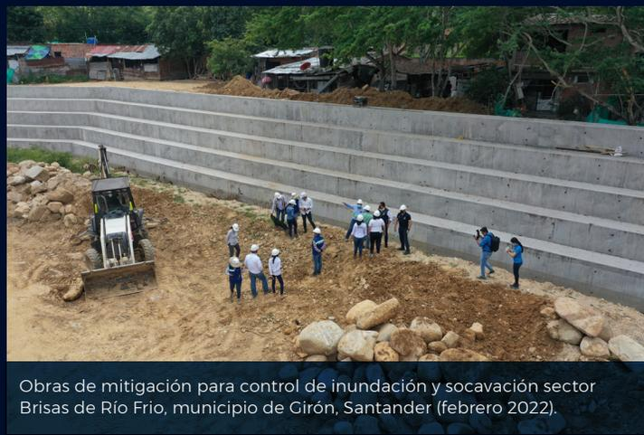
Obras de mitigación para control de inundación y socavación sector Brisas de Río Frio, municipio de Girón, Santander (febrero 2022).
