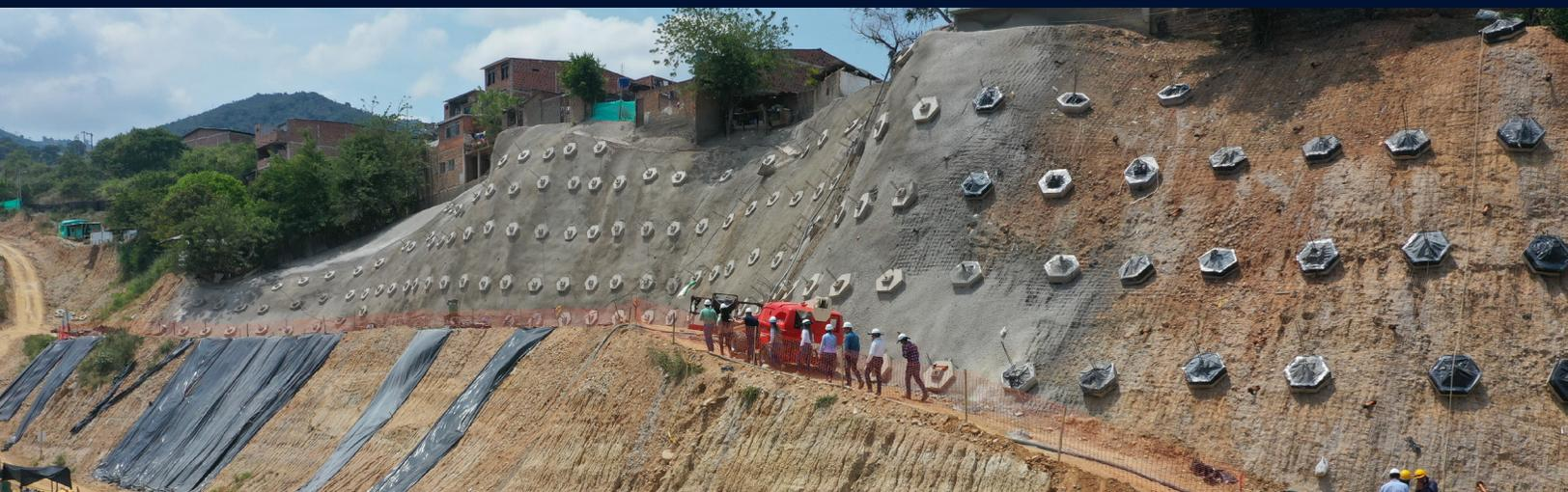
Obras de mitigación para control de inundación, socavación y remoción en masa sector Sagrado Corazón - Río Frio, municipio de Girón, Santander (febrero 2022).
