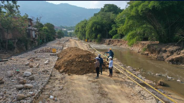
Obras de mitigación de amenaza por inundación y socavación entre los puentes vehiculares Lenguerke y Antonia Santos (Flandes), municipio de Girón, Santander (febrero 2022).
