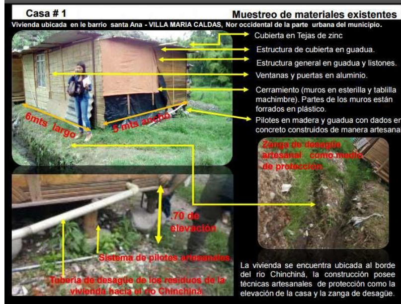
Imagen 13. Muestreo de materiales existentes de construcción de las viviendas del barrio Santa Ana - casa 1
