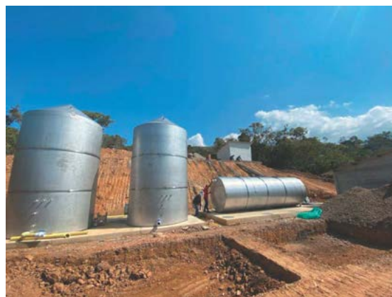
Construcción PTAR municipio de Encino
