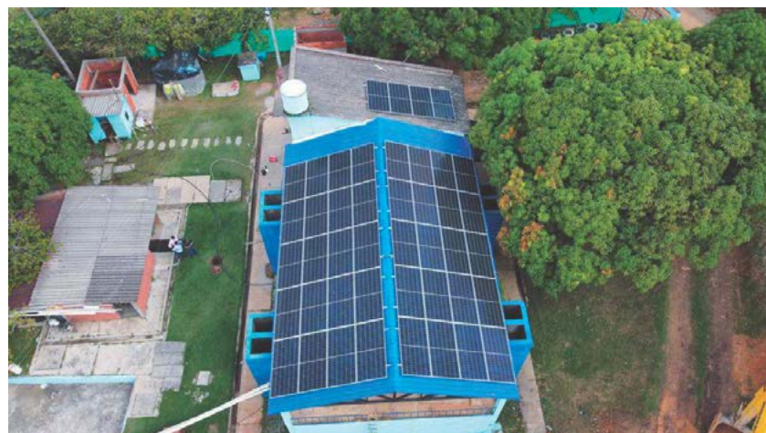
Sistemas fotovoltaicos PTAP Cimitarra – Santander.
