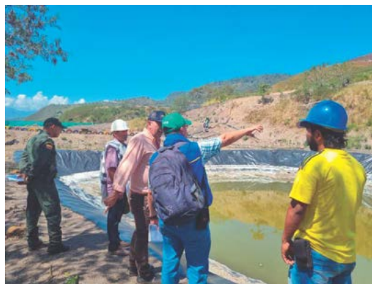
Piscina de lixiviados relleno sanitario San Gil (EMPSACOL)
