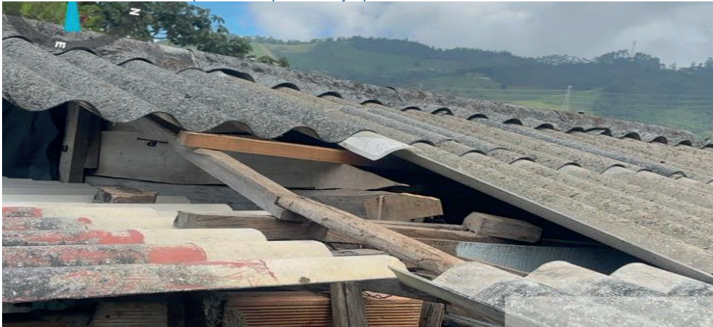
Ilustración 13 Viviendas con desprendimiento parcial de tejas por fuertes vientos
