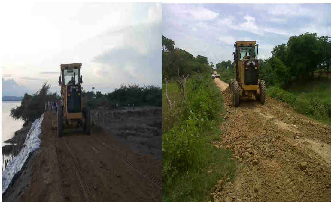
Fuente :Planeación Municipal-trabajos taponamiento boquete de San Luis, arreglo vía LosPatos.
