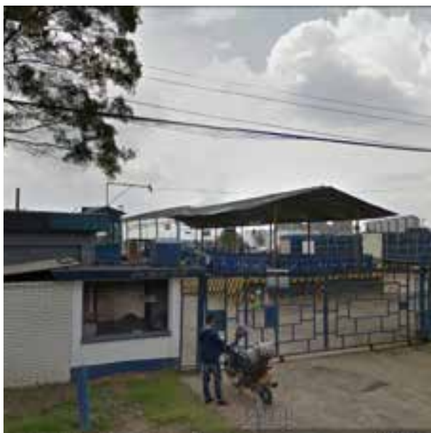
Escenario Conexo - Materiales Peligrosos – Derrame hidrocarburos - Carrera. 56 No. 19-78 - ECOPETROL
