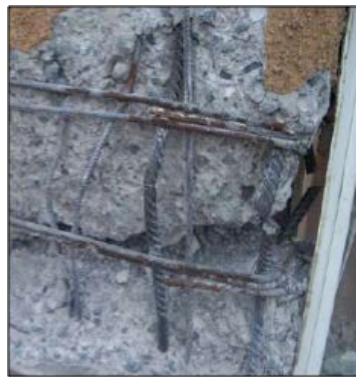
Deflexión y fractura del acero de refuerzo Fotografía tomada de: Metodología para la evaluación de la seguridad estructural de edificios, 2014
