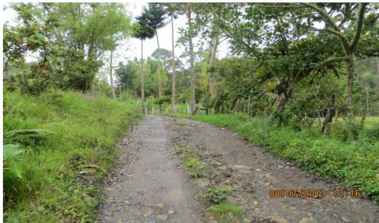
Fotografía 32. Vía de la vereda incomunicada a causa del deslizamiento.
