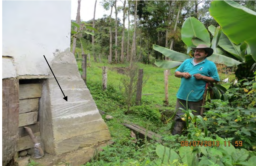
Fotografía 29. Refuerzo de columnas en vivienda.
