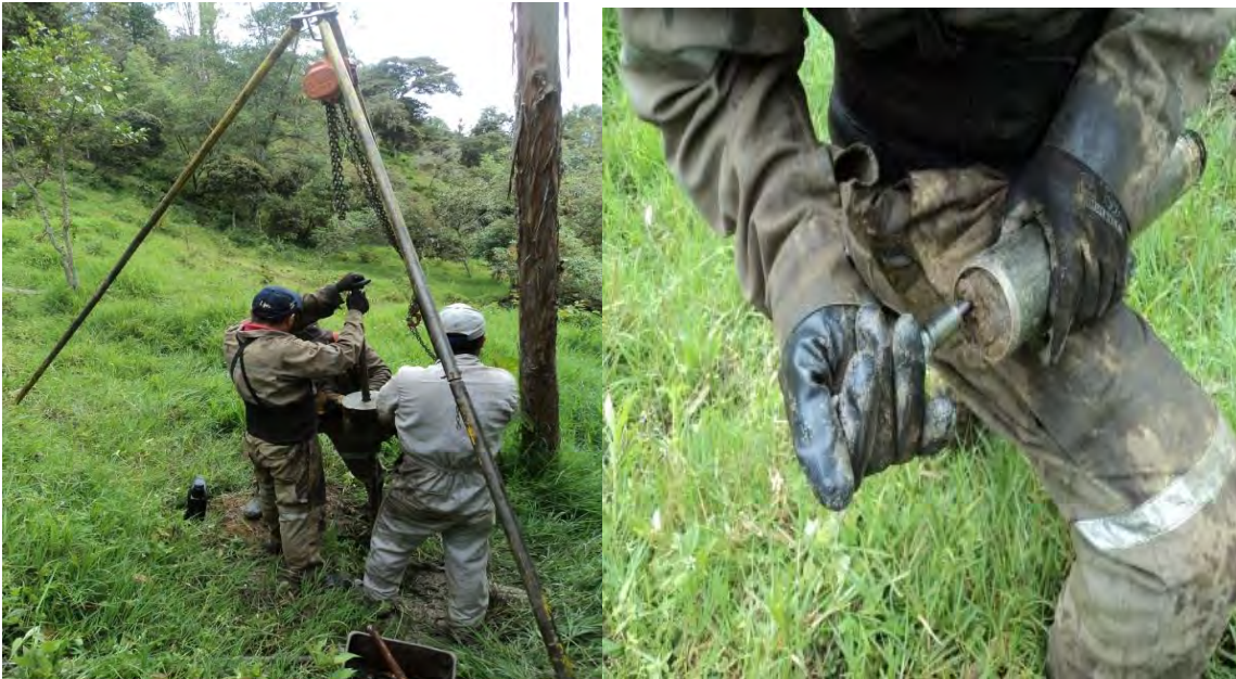
Fotografía 1. Exploración directa del subsuelo (SPT)
