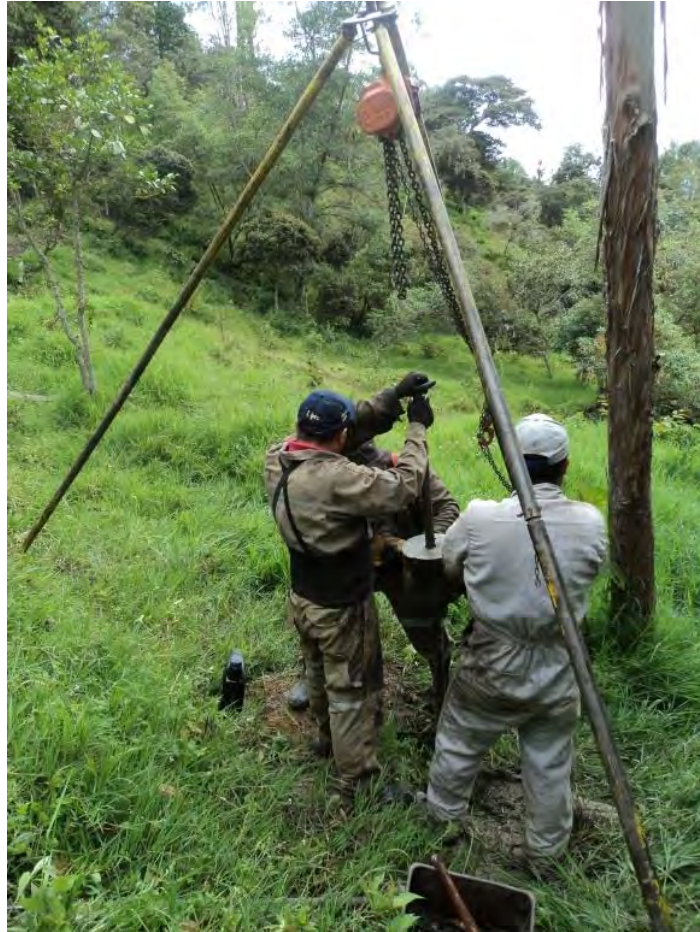
Fotografía 17. Perforación realizada en la zona de estudio
