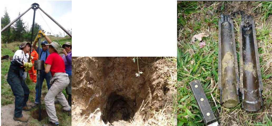
Fotografía 1. Exploración directa del subsuelo (spt)
