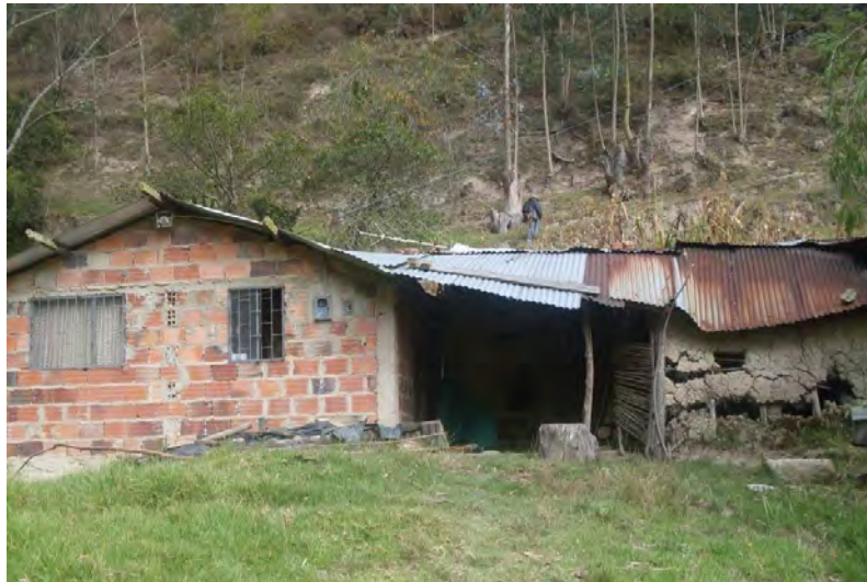
Fotografía 45. Refugio construido en latas y tablas de madera
