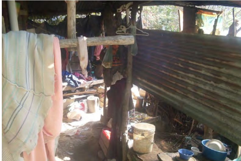
Fotografía 47. Estado de las viviendas
