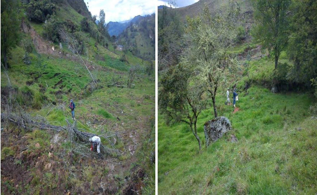
Fotografía 25. Parte alta del deslizamiento.
