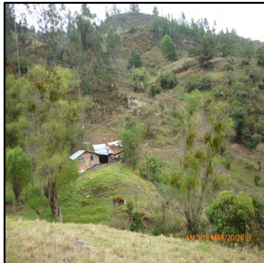
Fotografía 41. Vivienda ubicada dentro del Deslizamiento
