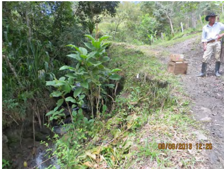
Fotografía 23. Campeño de la zona afectado por la afectación de la vía.
