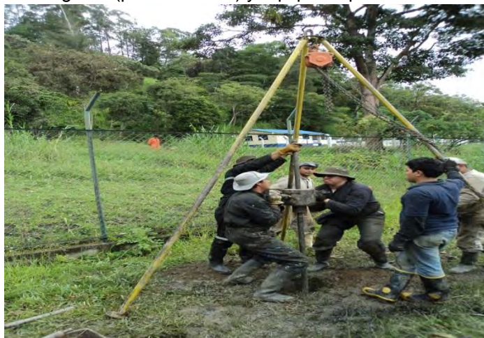
Fuente: Registro fotográfico.
