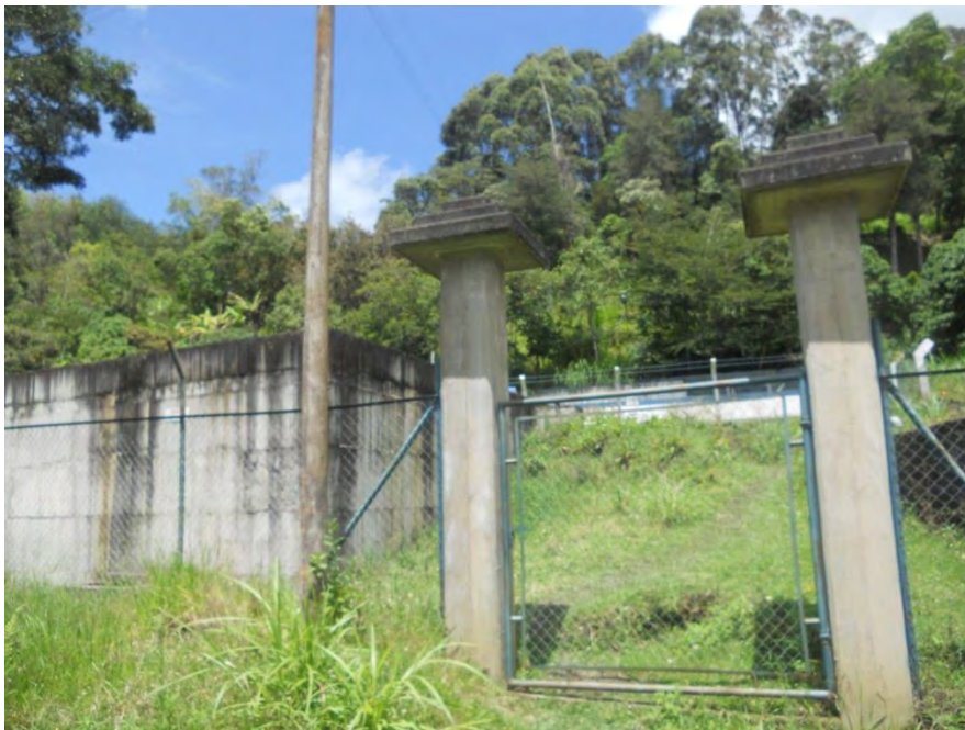
Fotografía 5. PLANTA DE TRATAMIENTO
