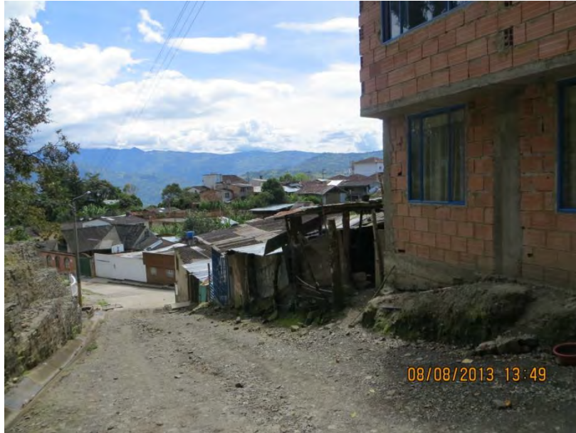
Fotografía 31. Zona urbana afectada por el movimiento del terreno.
