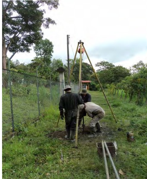
Fotografía 16. Perforación realizada en la zona de estudio
