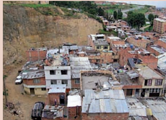
Fotos 2. Área de riesgo en zona marginal de Bogotá. Fuente: DPAE
