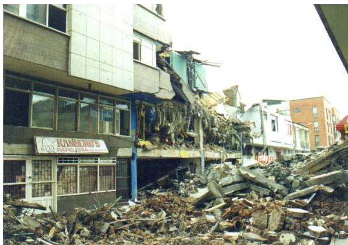
Figura 10: Colapso de edificaciones en zonas aledañas al centro de la ciudad, producidas por el sismo de enero de 1999 (sismo cercano).
