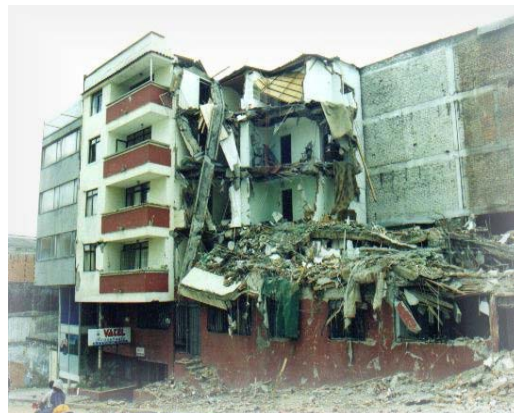
Figura 9: Colapso de edificaciones en la zona centro de la ciudad, producidas por el sismo de enero de 1999 (sismo cercano).
