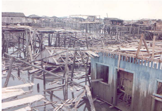
Figura 12. Destrucción de vivienda palafítica durante el terremoto de 1979.
