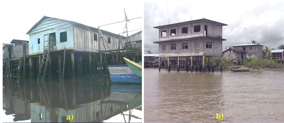
Figura 19. Cambio de materiales flexibles por rígidos. Viviendas sobre pilotes a) madera y b) concreto y ladrillo.
