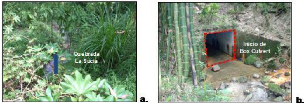
Figura 5. Quebrada La Sucia a) Cauce de la quebrada La Sucia, barrio Loma del Barro. b) Inicio de cobertura en box culvert, sector Señorial.
