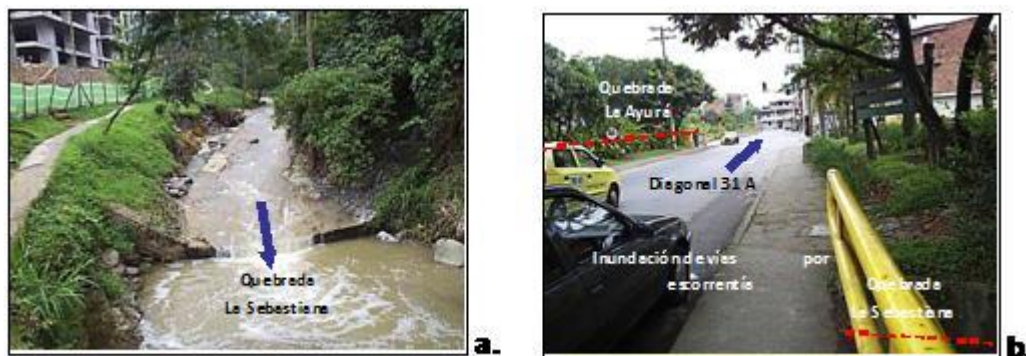
Figura 4. Quebrada La Sebastiana. a) Cauce de la quebrada La Sebastiana, sector La Inmaculada. b) Posible inundación de vías por escorrentía en el sector de la confluencia con la quebrada La Ayurá.
