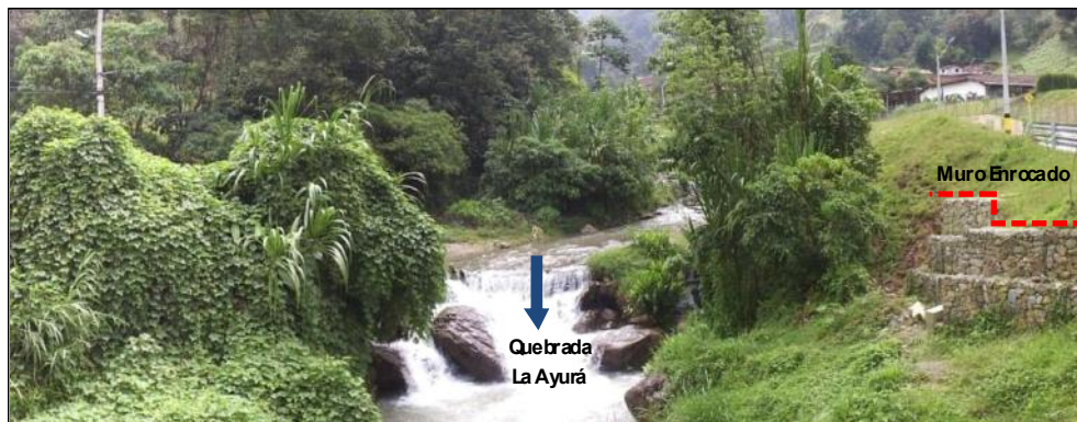
Figura 9. Quebrada La Ayurá a la altura del puente La Pava. Obsérvese el muro levantado hacia la margen izquierda, que pretende impedir que el flujo afecte las construcciones aledañas representadas por una placa polideportiva y algunas viviendas.
