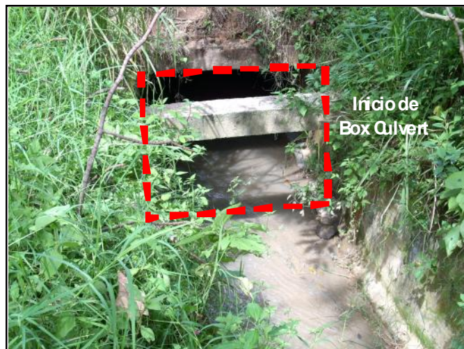
Figura 19. Inicio de cobertura en box culvert para la quebrada La Heliadora en el barrio La Paz.
