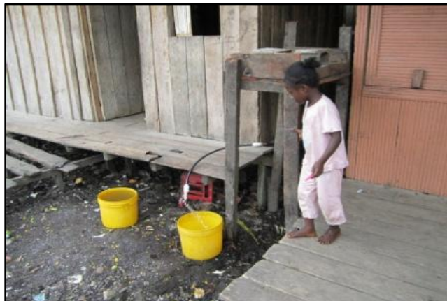
Conexión irregular al acueducto
