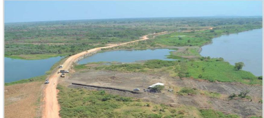
Obras de mitigación para el control de la inundación del chorro La Victoria y reforzamiento del jarillón.
