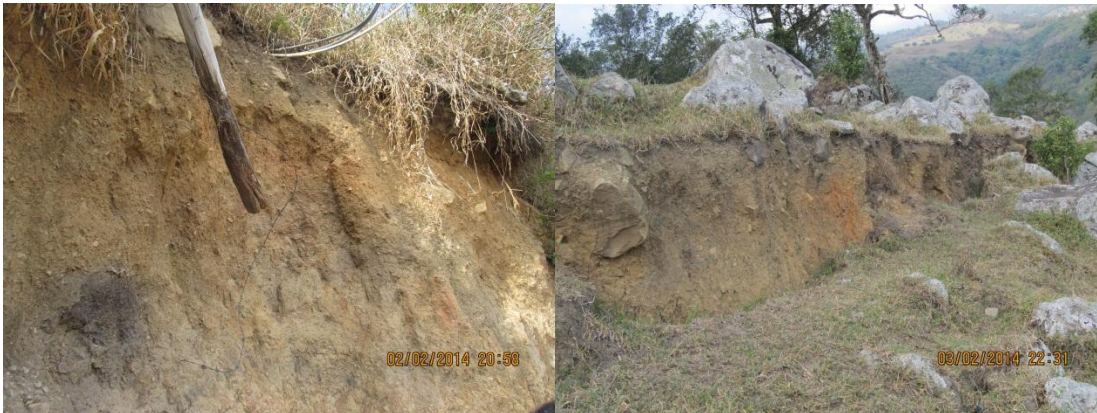
Fotografía 6.5 Vista de la unidad de depósito Coluvial arenoso expuestos en el la corona del deslizamiento
