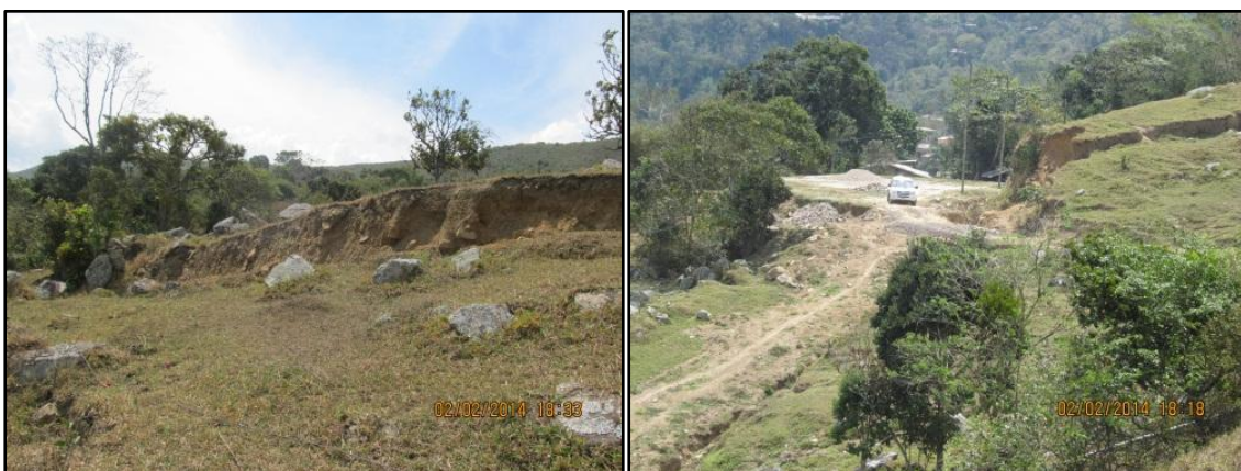
Fotografía 6.20 Vistas parciales del sistema de grietas del movimiento
