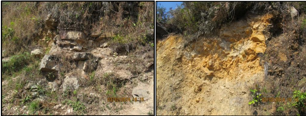
Fotografía 6.1 Exposición de las areniscas de la formación Barco en condición de roca muy fracturada
