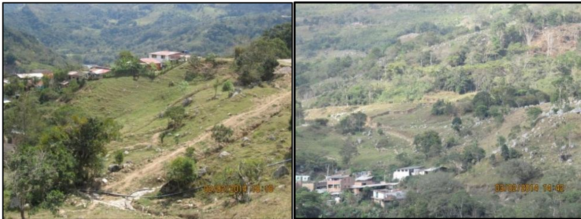
Fotografía 6.18 Condición actual de uso del suelo (pastos) en la zona afectada por el deslizamiento
