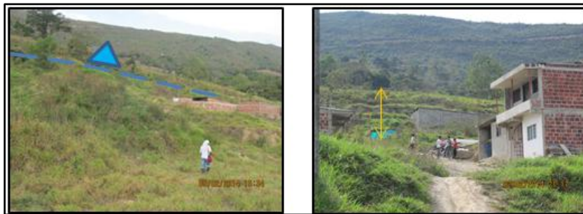
Fotografía 6.23 Vista del sector posterior del lote, afectado por el nivel freático colgado del sector occidental del predio
