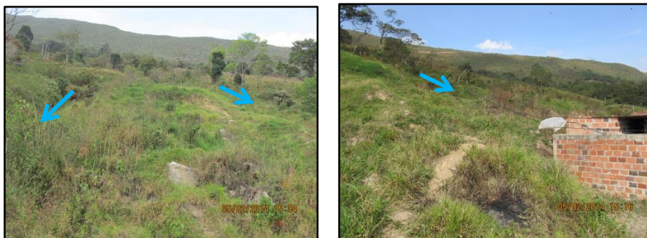
Fotografía 6.24 Vista del límite occidental de la zona de reubicación, afectada por la afluencia de aguas sobre el talud superior, con procesos de reptación y formación de flujos de tierras
