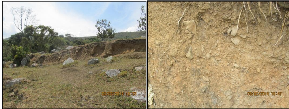
Fotografía 6.15 Vista de la unidad coluvial Lc2 afectada por el deslizamiento.
