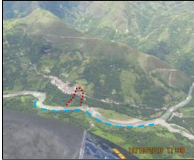
Figura 2.2 Vista aérea zona de deslizamiento
