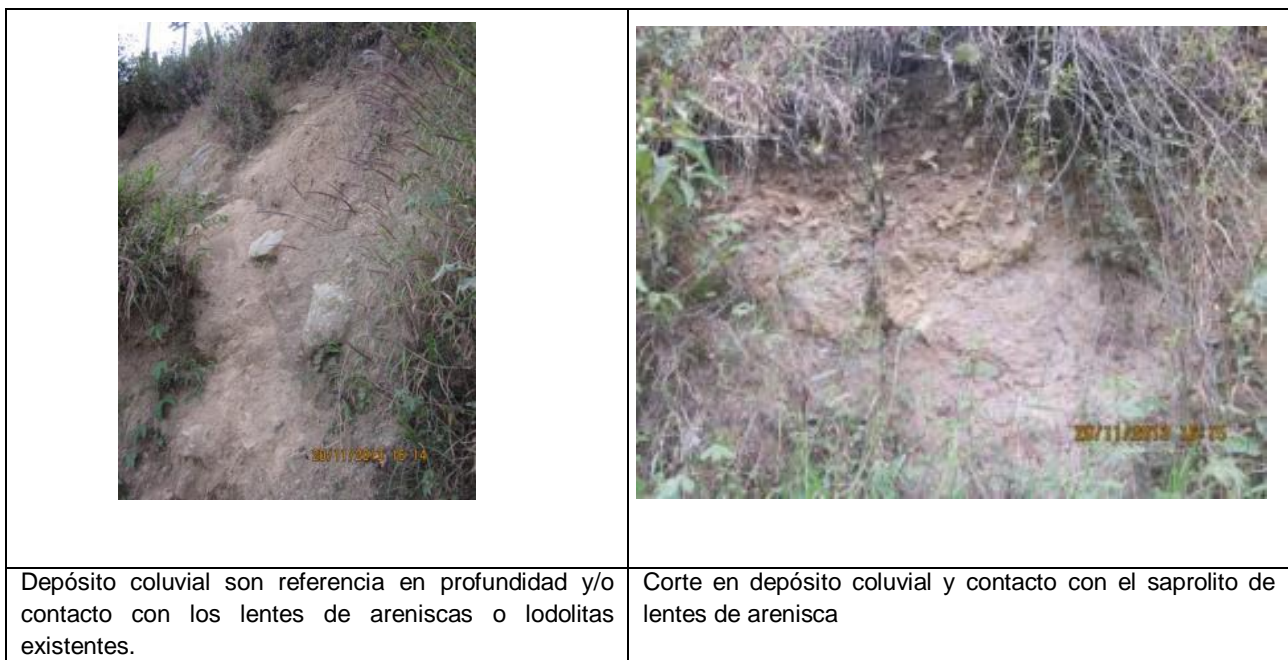
Fotografía 7.3 Características del Depósito Coluvial
