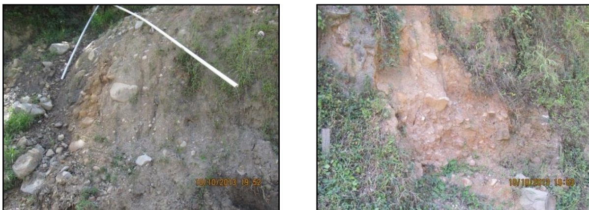
Fotografía 6.6 Vista de los depósitos aluviales del nivel de terraza, expuestos en el sitio contiguo al deslizamiento
