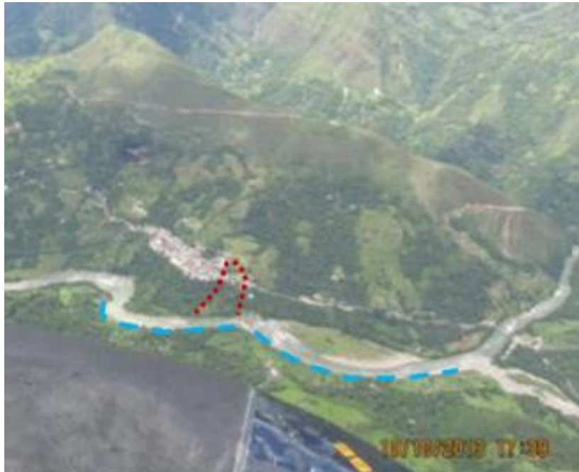
Figura 7.1 Vista área zona de deslizamiento
