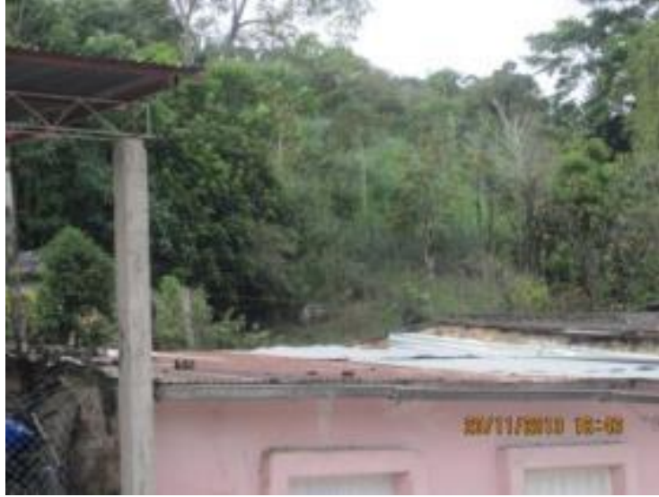
Depósito coluvial hacia la parte superior de las viviendas existentes. No se observa inestabilidad evidente
