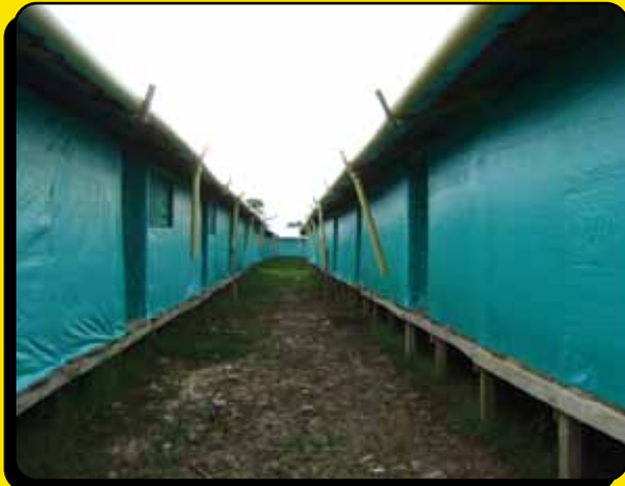
Corregimiento Santiago Apóstol, San Benito Sucre. Foto OIM. 2011
