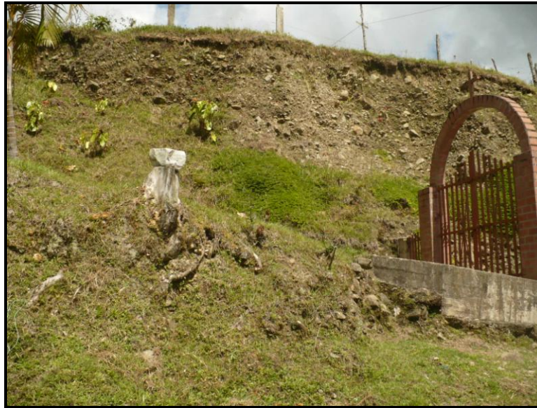
Fotografía 3-2 Aspecto general del depósito que forma el abanico de Abriaquí
