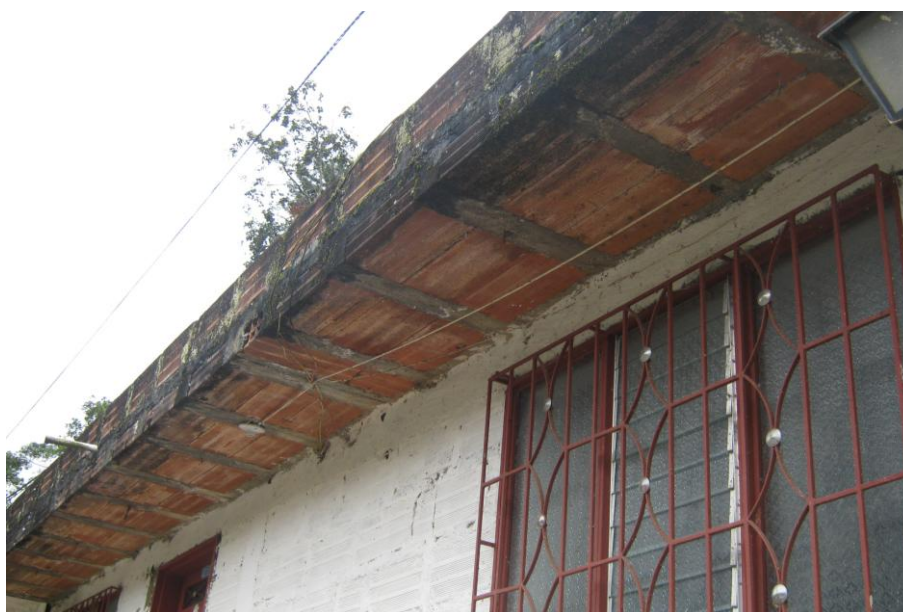
Fotografía 4 - 12 Placa de entrepiso aligerada con bloque.
