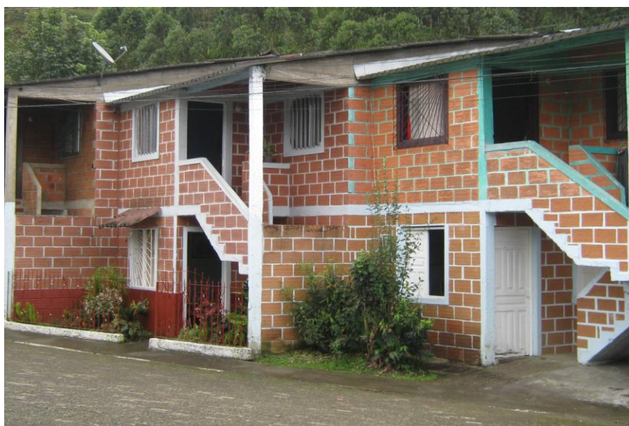
Fotografía 4 - 9 Viviendas en Mampostería.
