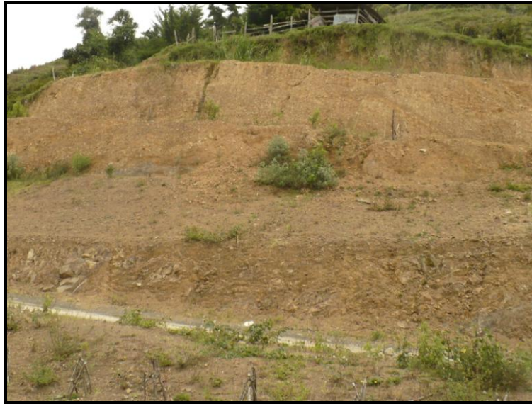
Fotografía 3-6 Sitio donde se levantó el perfil de meteorización de la unidad de suelos residuales de sedimentitas, vía Abriaquí – Frontino, Km. 1
