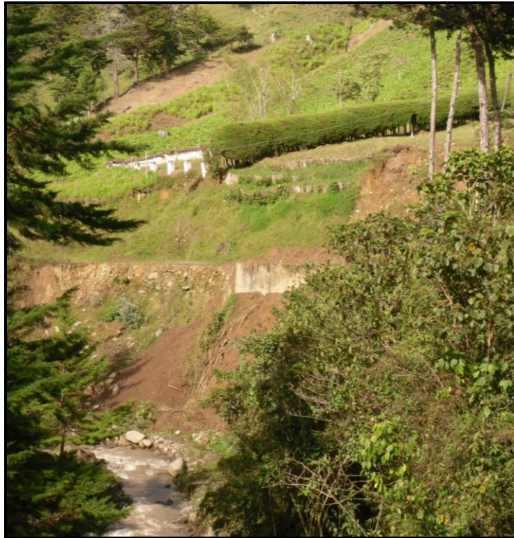
Fotografía 3-10 Proceso de remoción en masa, zona del cementerio
