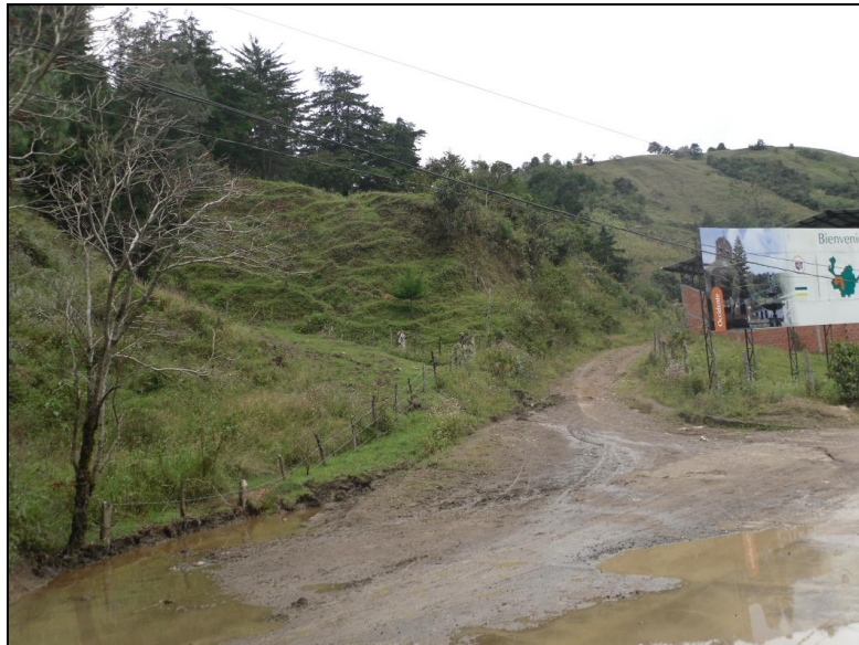
Manejo Fotografía 3-14 Estado de las Vías – Vía a Cañasgordas
