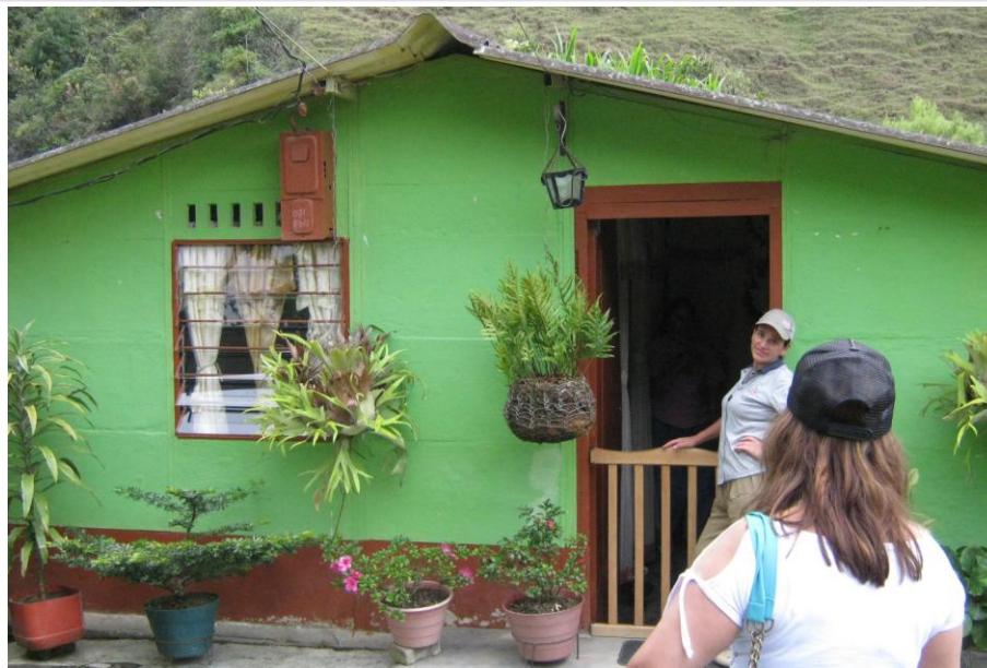
Fotografía 4 - 10 Viviendas con muros Prefabricados.
