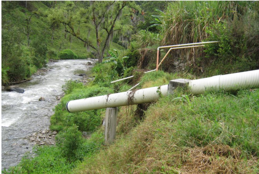
Fotografía 4 - 13 Disposición final de aguas lluvia y servidas en el Municipio de Abriaquí.
