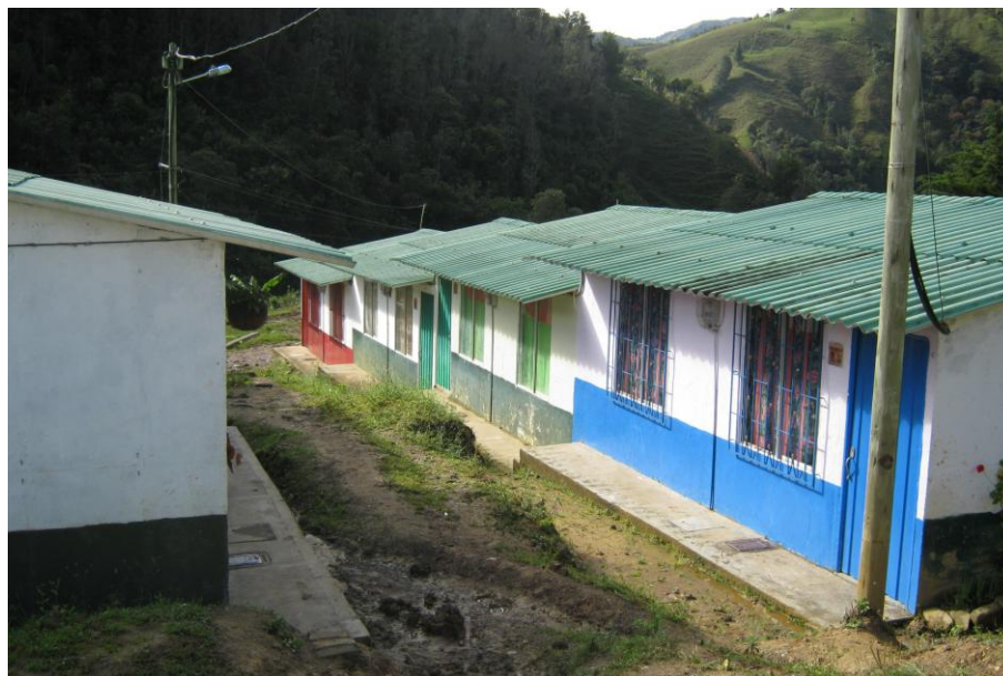
Fotografía 4 - 11 Viviendas del barrio El Porvenir.
