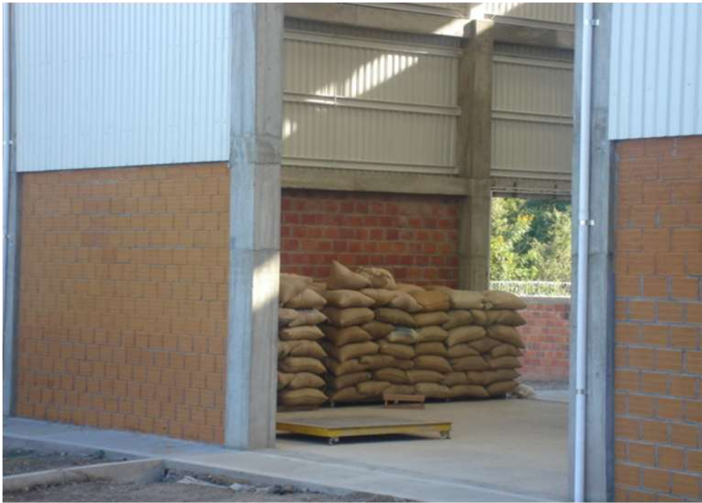
Figura 81. Bodega de Coagrobrisas para el almacenamiento de café pergamino seco, municipio del Pital
